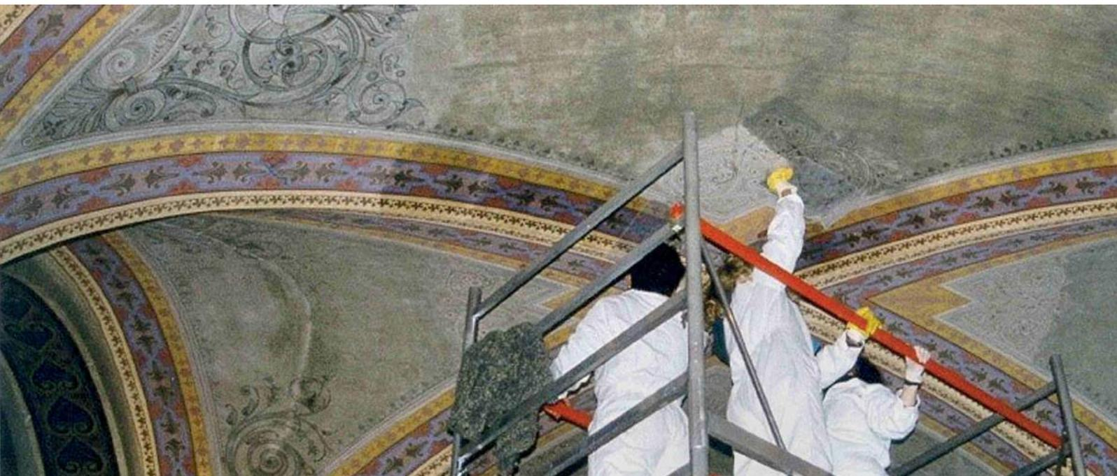
Fig. 3 Operazioni di pulitura e di consolidamento delle pitture murali a tempera.
