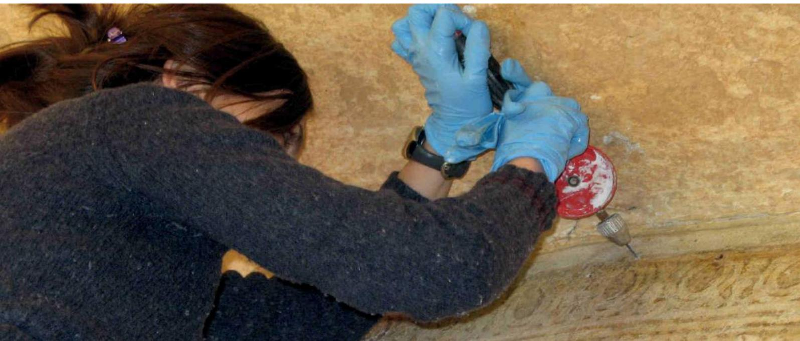
Fig. 33 Perforazione dell'intonaco per il consolidamento dei distacchi tramite iniezione di apposita malta.
