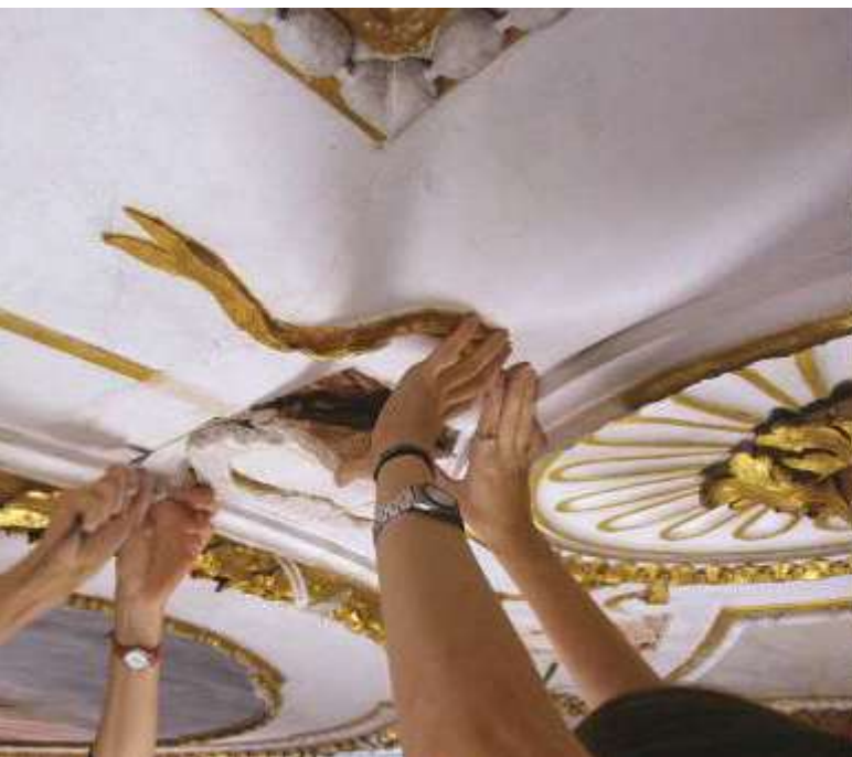
Fig. 20 (a sinistra) Ispezione della copertura: si è aperto un tassello nell'intonaco del soffitto per verificare lo stato di conservazione delle strutture metalliche che tengono fissato il soffitto alla copertura.
