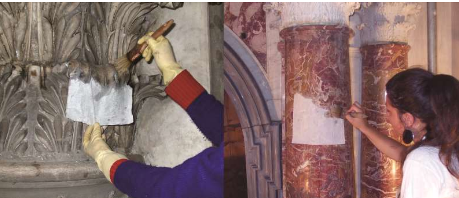
Figg. 38 (a sinistra) e 39 (a destra) Operazioni di pulizia degli elementi architettonici in pietra e marmo.
