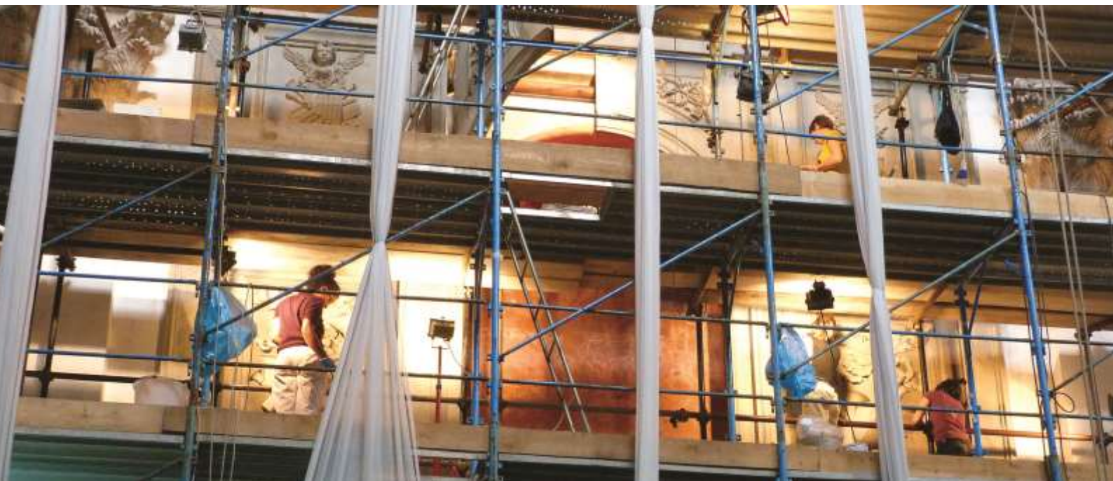
Fig. 49 Vista del cantiere durante i lavori di restauro.
