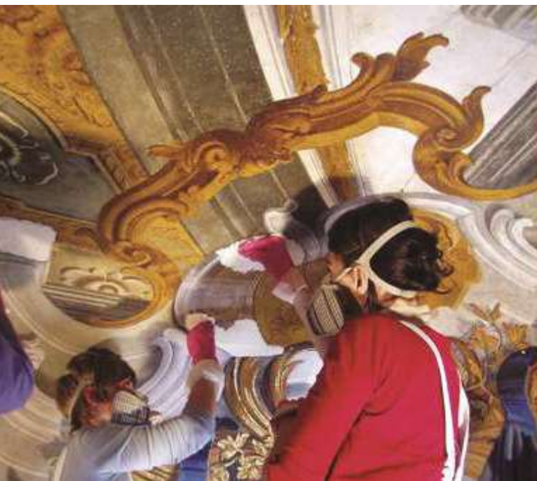
Fig. 7 (a sinistra) Pulitura del soffitto.
