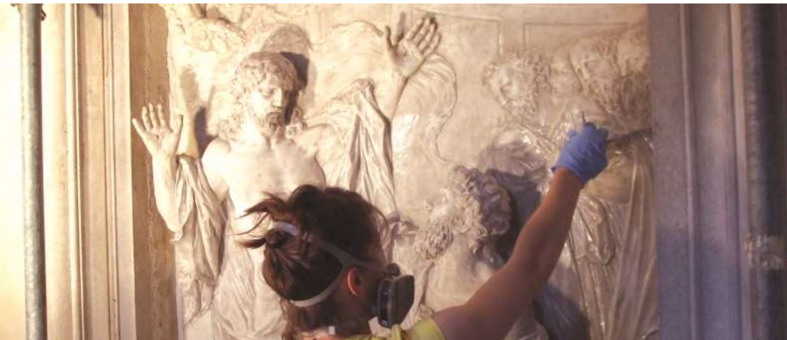
Fig. 40 Operazioni di restauro del rilievo Battesimo di Cristo .
