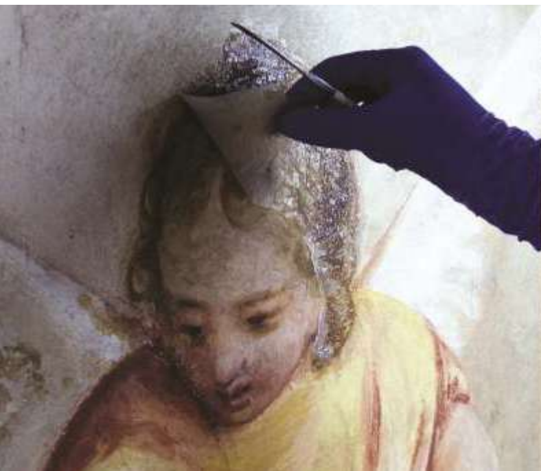
Fig. 86 (a sinistra) Pulitura degli affreschi con impacchi di carbonato d'ammonio in agar agar.
