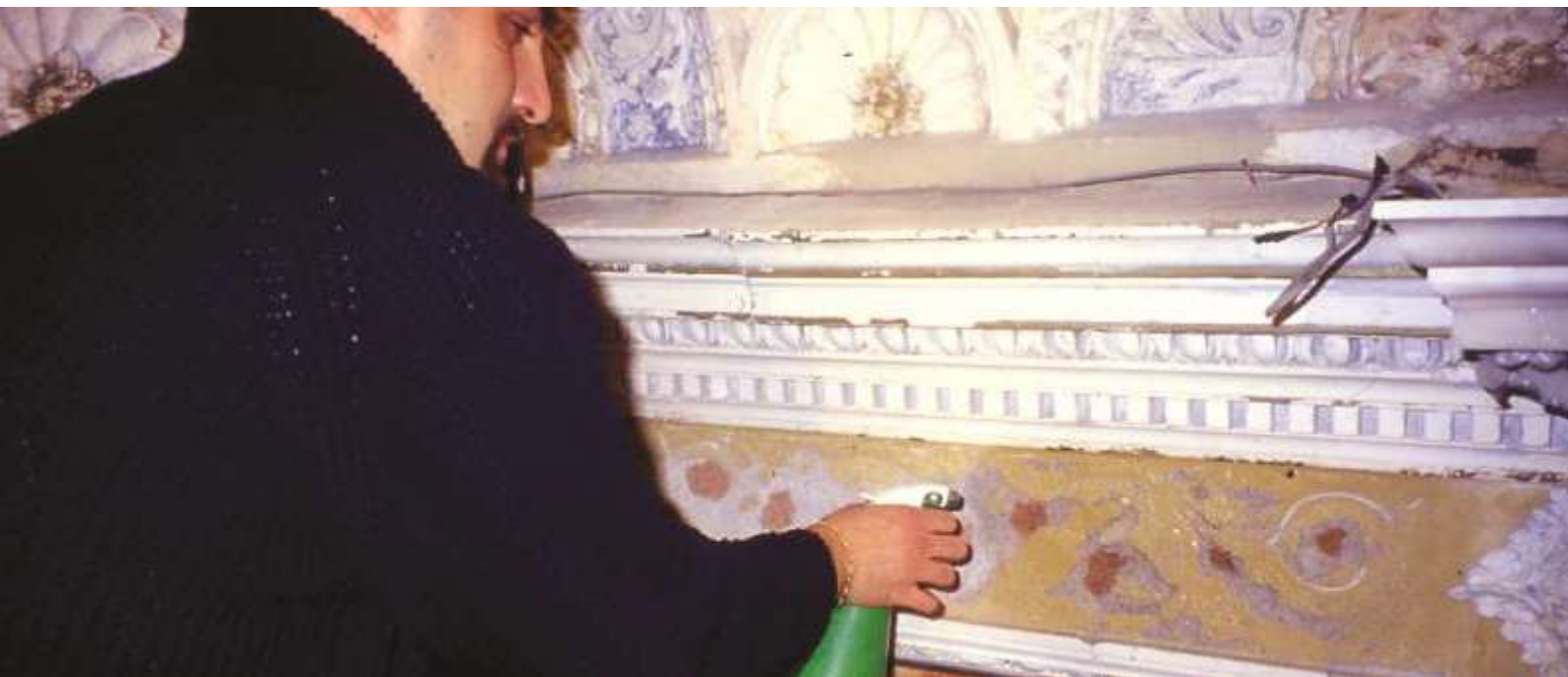
Fig. 73 Consolidamento degli stucchi e degli intonaci.
