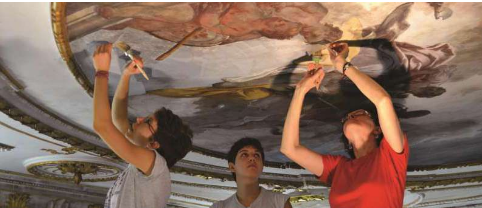
Fig. 16 Velinatura delle parti più deboli della pellicola pittorica prima della pulitura del soffitto.
