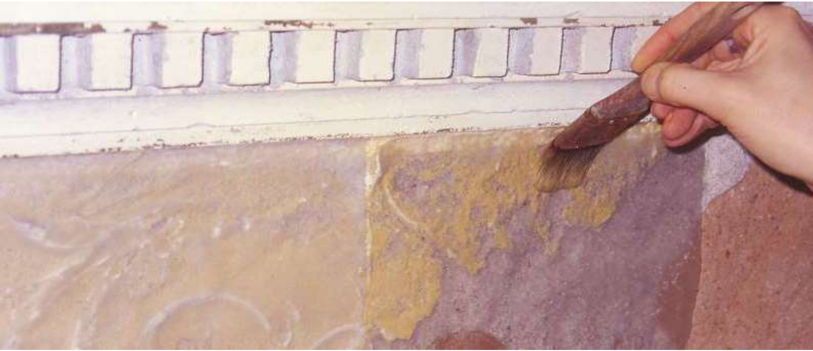
Fig. 76 Consolidamento con idrossido di calcio.
