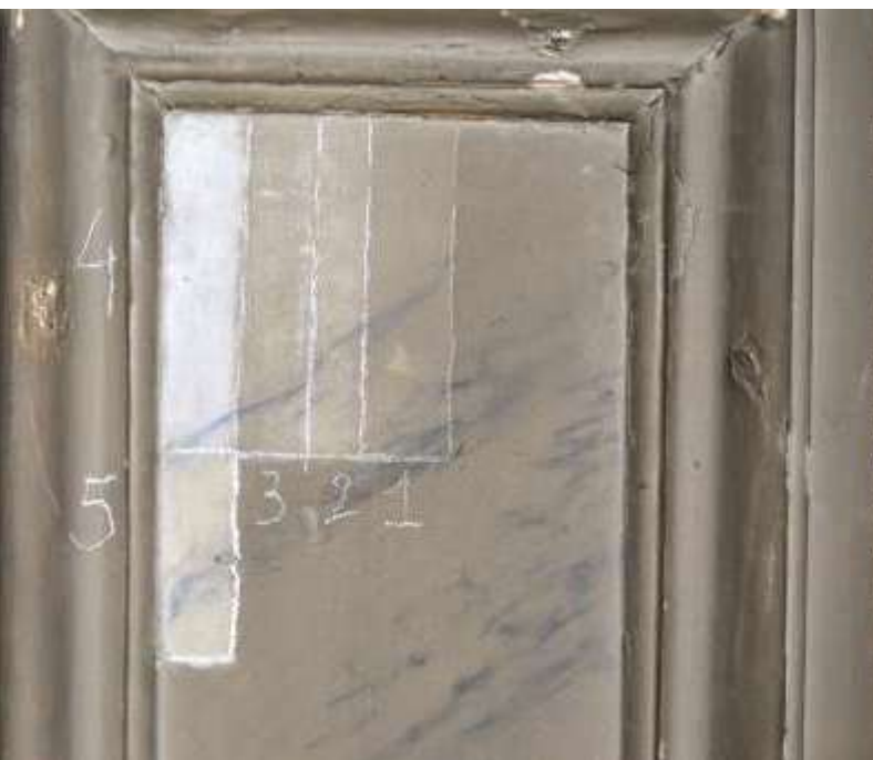
Fig. 47 (a sinistra) Test di pulitura eseguiti sulla superficie ridipinta per individuare lo strato da mettere in evidenza. Fig. 48 (a destra) Dettaglio dei rilievi del ballatoio durante la pulitura.
