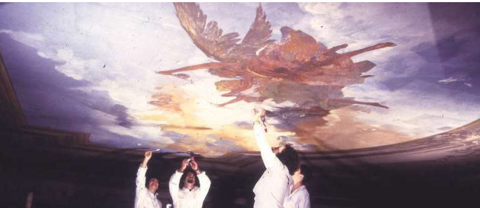
Fig. 102 Ritocco pittorico con colori acquerelli.
