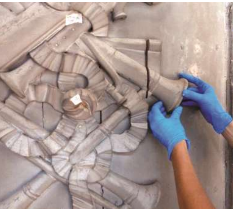
Fig. 45 (a sinistra) Fissaggio di un elemento disgiunto dei rilievi raffiguranti strumenti musicali nella sezione più alta della cantoria.
