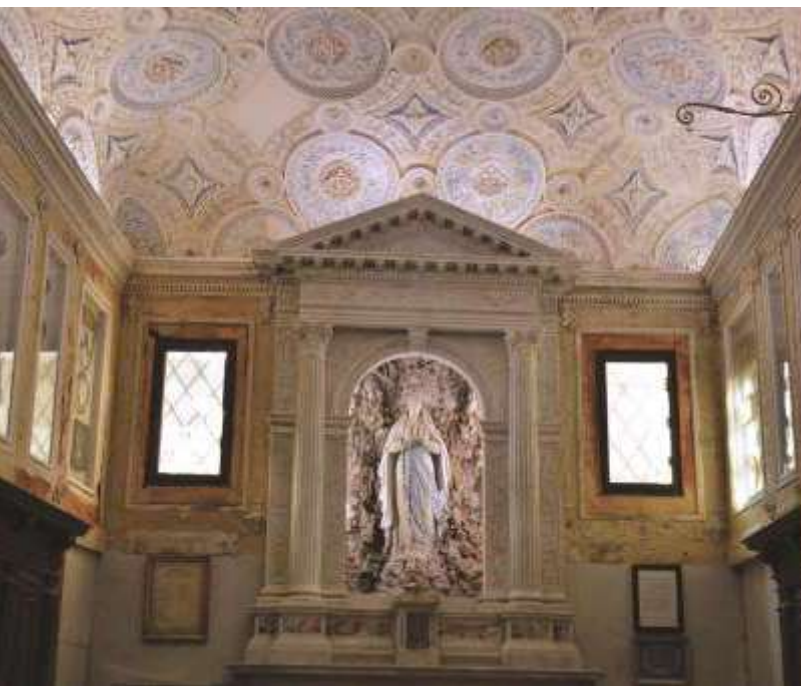
Fig. 71 (a sinistra) Dettaglio della nicchia in cui è conservata la statua della Vergine, con rivestimento interno simulante la grotta di Lourdes. Foto dopo il restauro.
