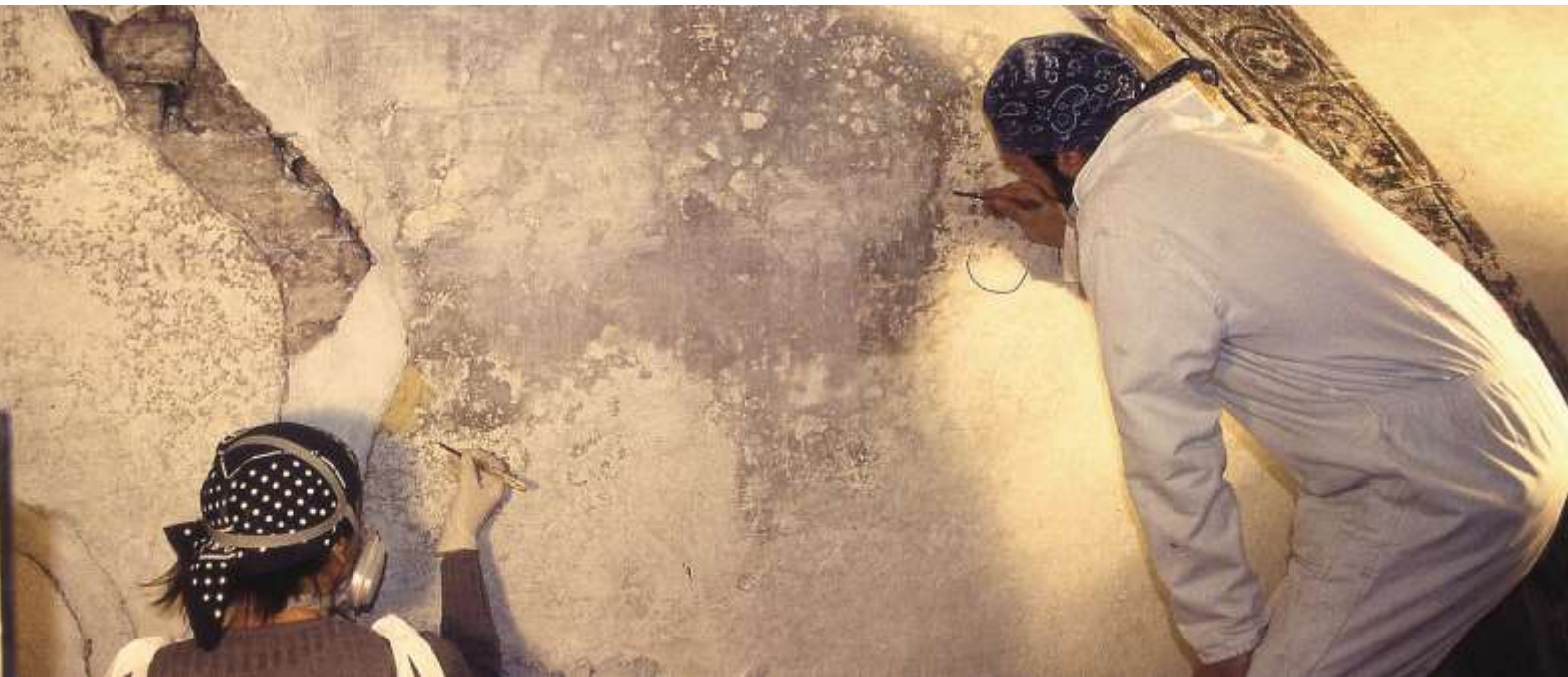
Fig. 63 Operazione di descialbo a bisturi delle superfici ridipinte del presbiterio.
