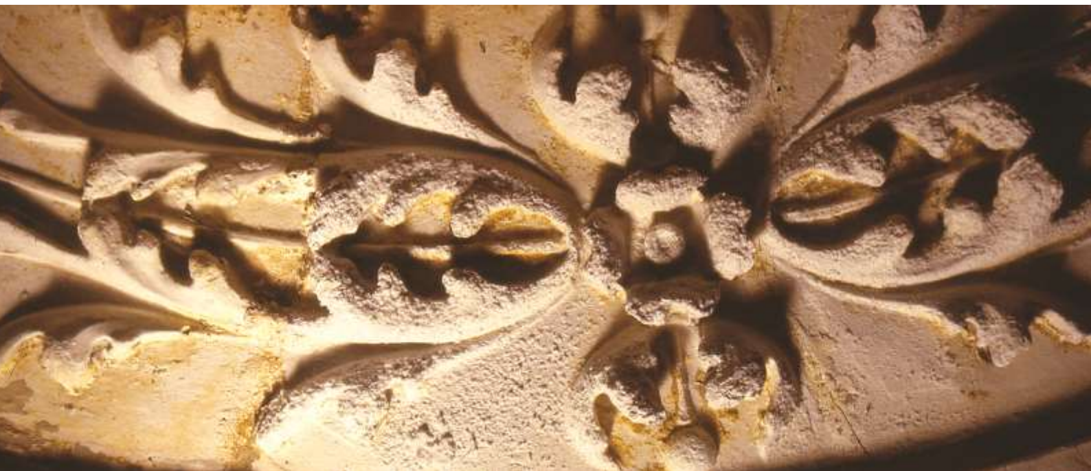
Fig. 75 Dettaglio della stato di conservazione degli stucchi, con evidenti incrostazioni saline, foto in luce radente, prima del restauro.
