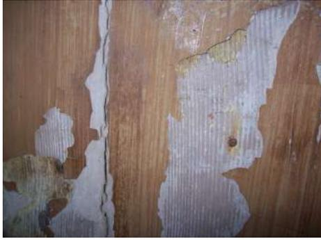
(Foto 4.1: particolare della parete con evidente caduta della vernice ed esposizione di un chiodo arrugginito)
