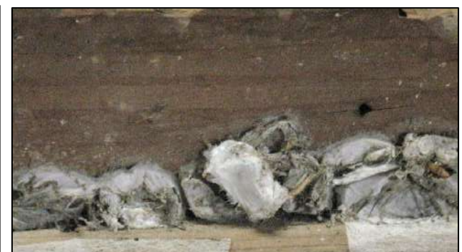
61, 62, 63, 64, 65, 66. Solco che ha segnato il listello, nodo del legno, sistema di ancoraggio alla parete ossidato, chiodo che ha fessurato il legno, residui di colla degli angoli, bozzoli di insetti.
