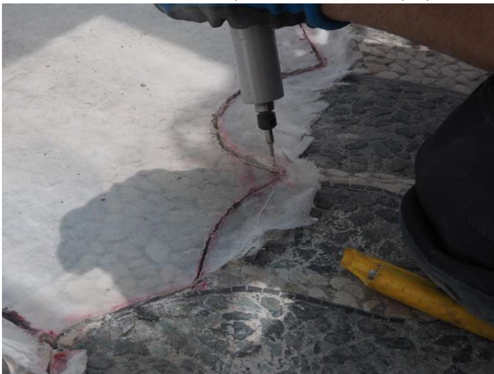
Figura 42. Taglio effettuato negli angoli più delicati con l'aiuto di una piccola fresa.
