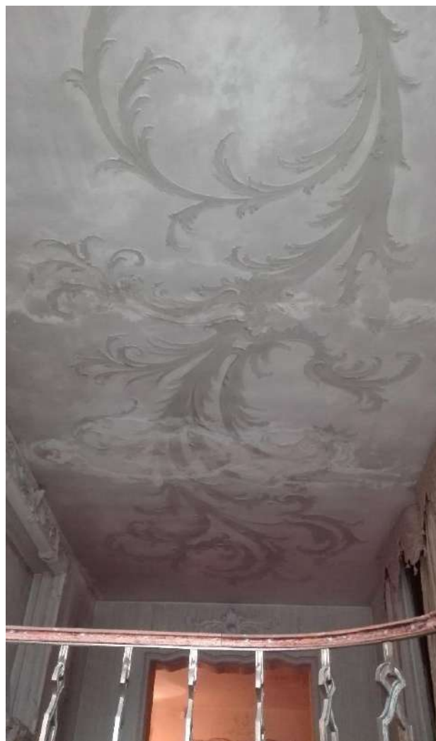
Figura 32. Rilievo che mette in luce le fessurazioni e i giunti di dilatazione lungo le linee che tripartiscono verticalmente il piano della superficie.
