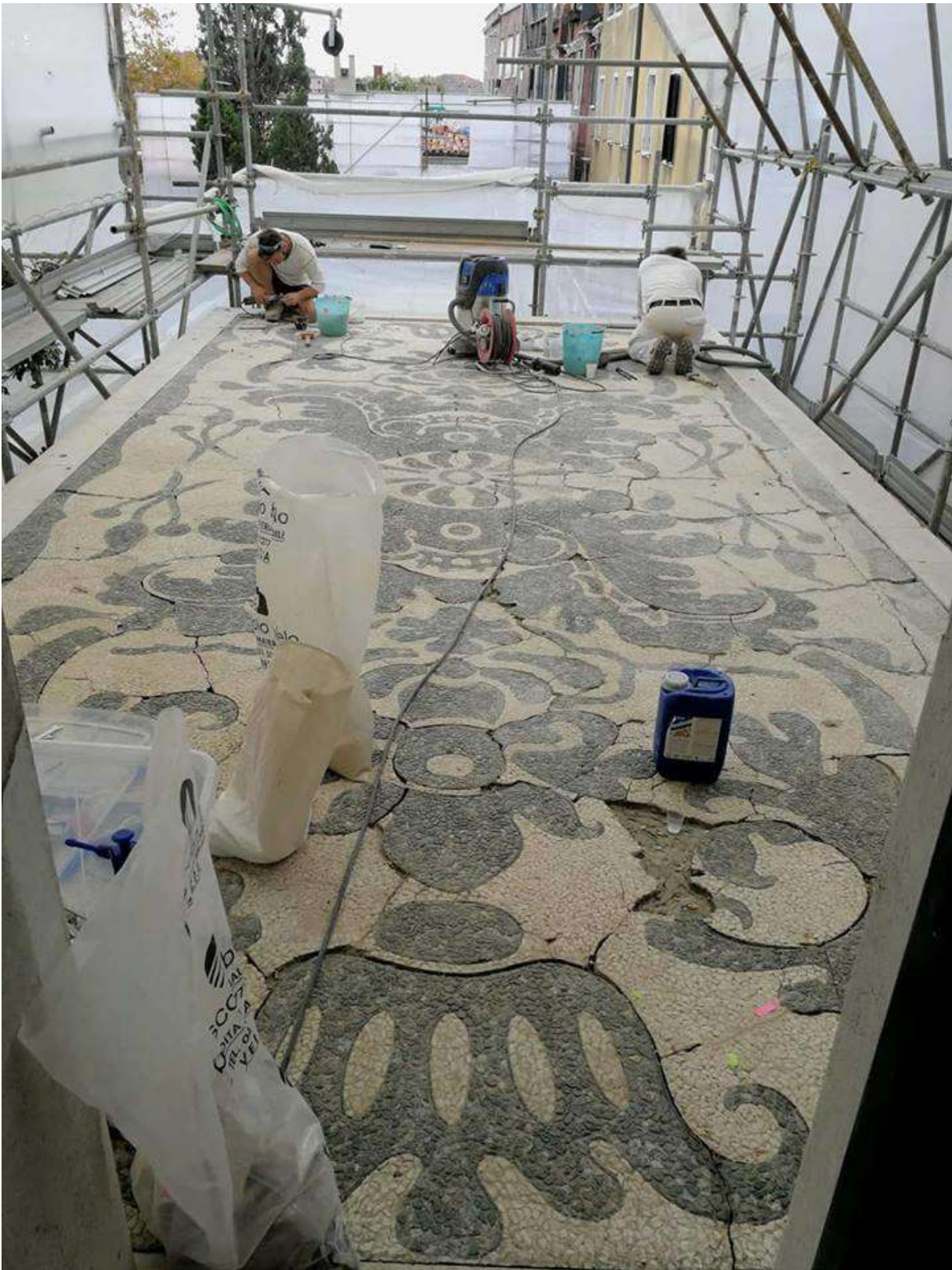
Figura 66. I lavori di stuccatura continuano.
