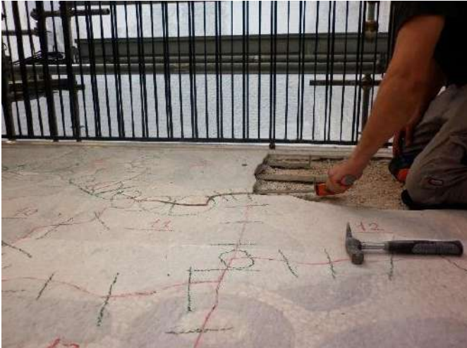
Figura 43, 44. Inserimento delle "spade" sotto il primo strato di cocchiopesto. Con l'aiuto di una mazzetta si batte la parte della spada piegata, in modo da sollevare, già in buona parte, il cocchiopesto.
