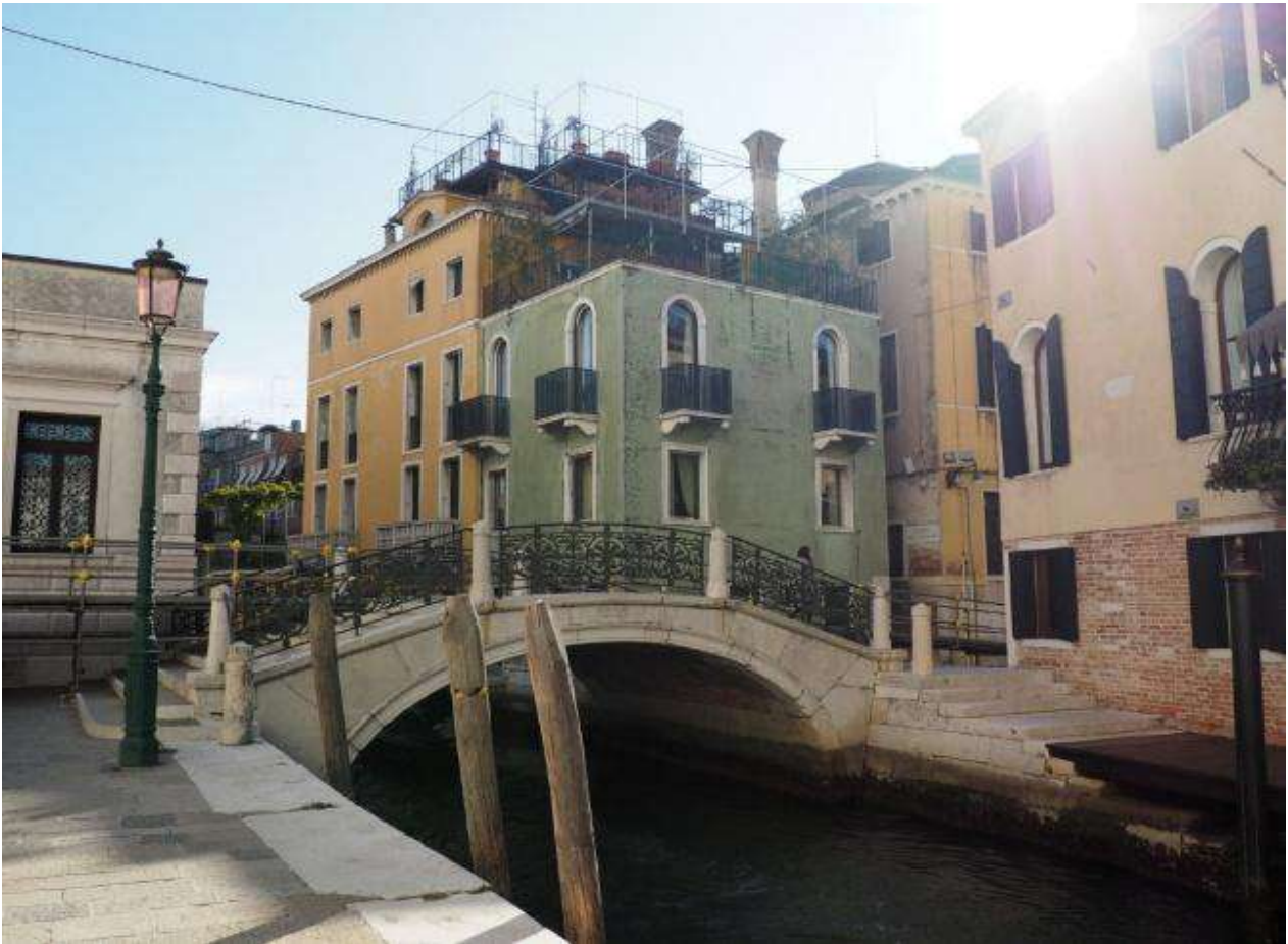
Figura 1. Fronte Nord del palazzo, rivolto verso il campo della Salute
