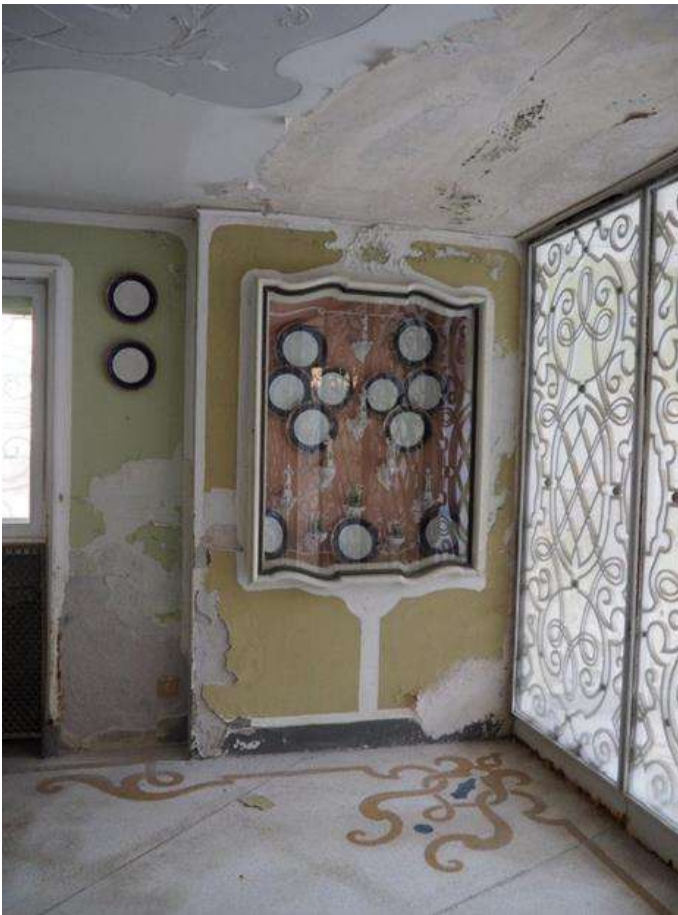
Figura 24, 25. Sala da pranzo al pianterreno: la risalita capillare incrementata dal contatto diretto con il canale e le problematiche del solaio hanno compromesso l'intero apparato murario.
