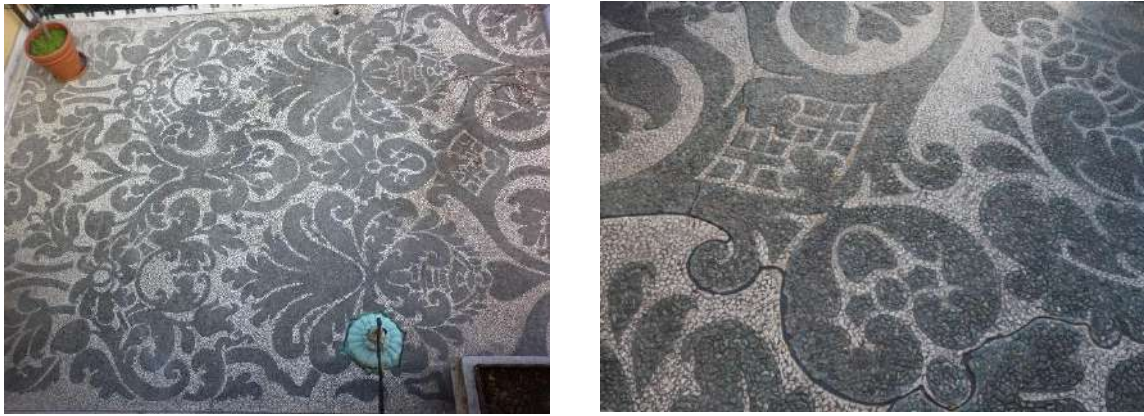
Figura 17, 18. Le terrazze al primo e terzo piano.
