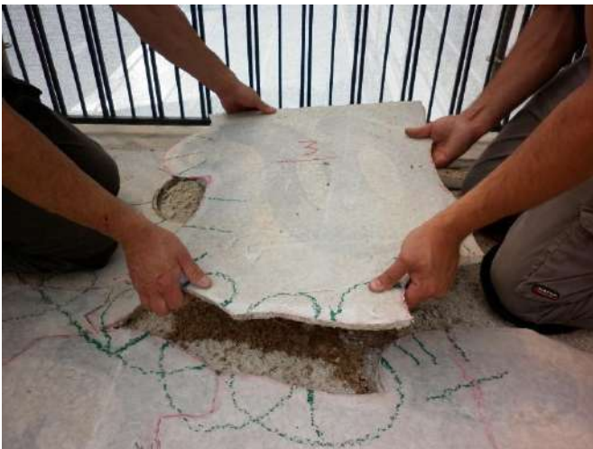
Figura 45, 46. Il distacco e sollevamento delle sezioni prima della fase di stoccaggio.
