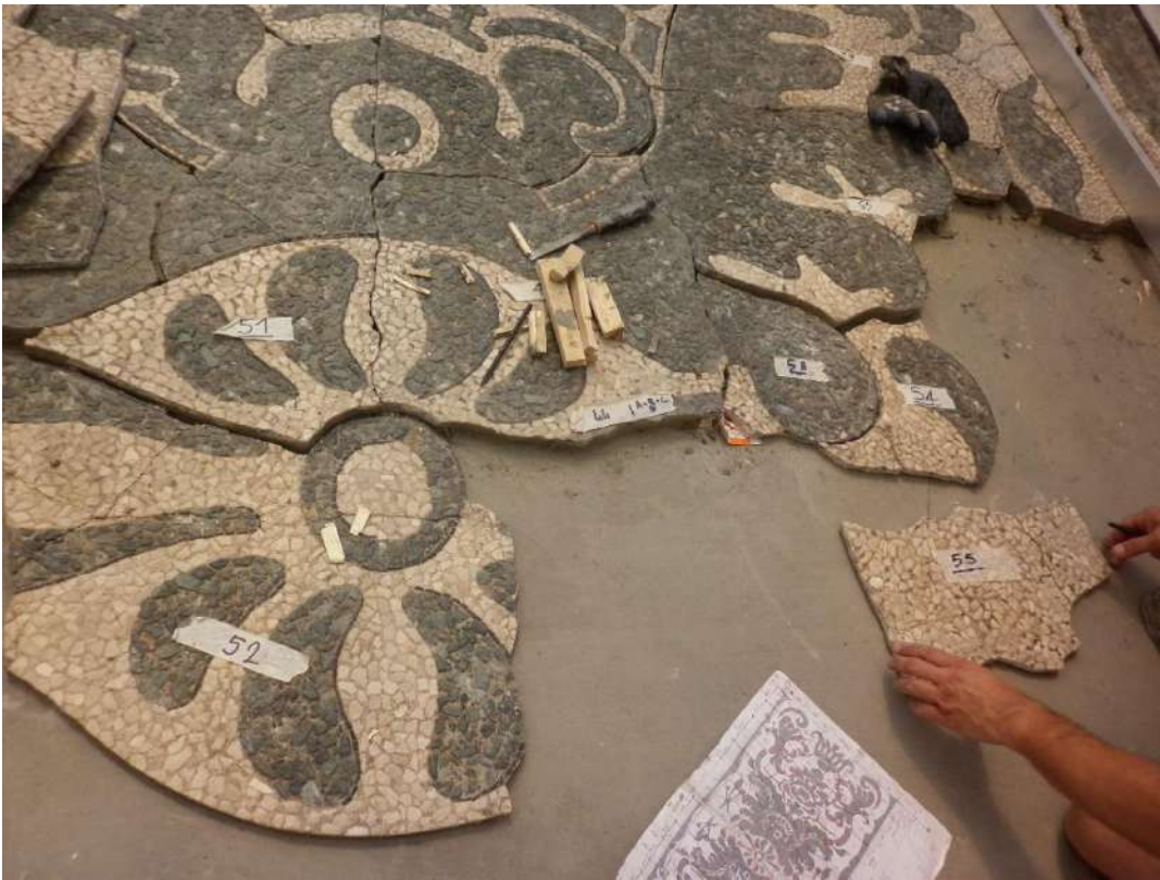
Figura 62. Studio e calibrazione della posizione delle sezioni, i tasselli di legno, vengono usati da supporto temporaneo prima della posa della colla cementizia, per livellare i piani d'appoggio.
