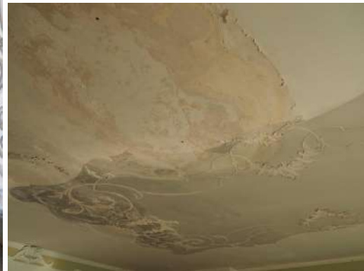
Figura 24, 25. Sala da pranzo al pianterreno: la risalita capillare incrementata dal contatto diretto con il canale e le problematiche del solaio hanno compromesso l'intero apparato murario.
