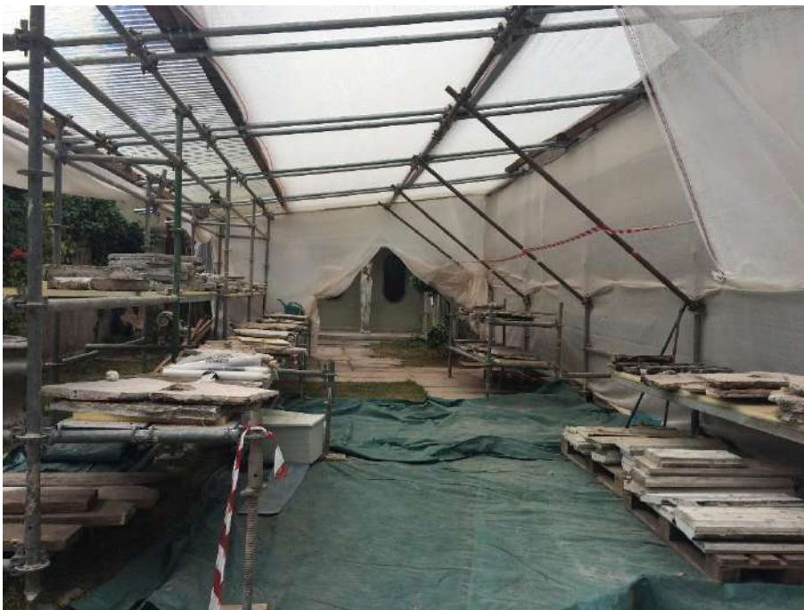
Figura 51. Sede impalcata per lo stoccaggio e la lavorazione delle sezioni del pavimento.
