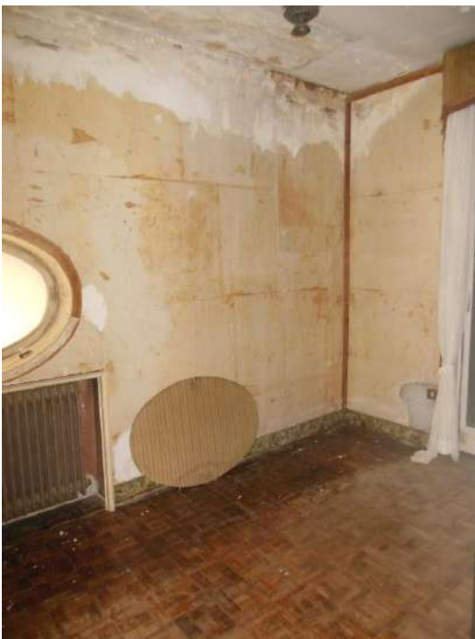
Figura 28, 29. Cameretta al piano secondo: i danni causati dalle infiltrazioni sono ingenti.
