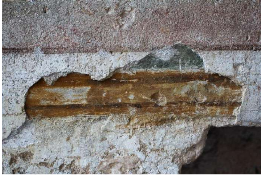
Figura 15: La sbrecciatura che lascia intuire la presenza di un affresco sottostante
