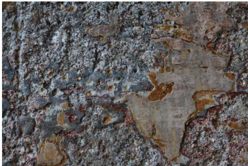
Figura 16: Tracce di colore nell'angolo in basso a destra coperta in parte da residui di scialbo
