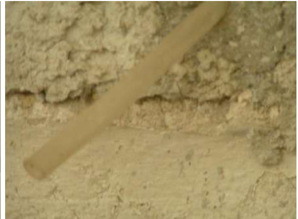
Figura 44: L'inserimento delle cannule
