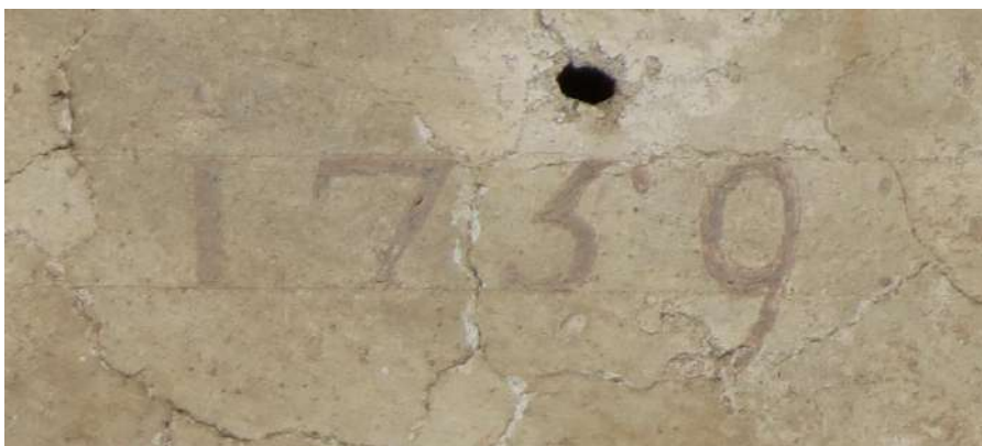
Figura 5: Particolare dell'affresco in via Monte Grappa: la cifra 5 che, a causa di una microfessurazione dell'intonaco, era stata scambiata per un 3
