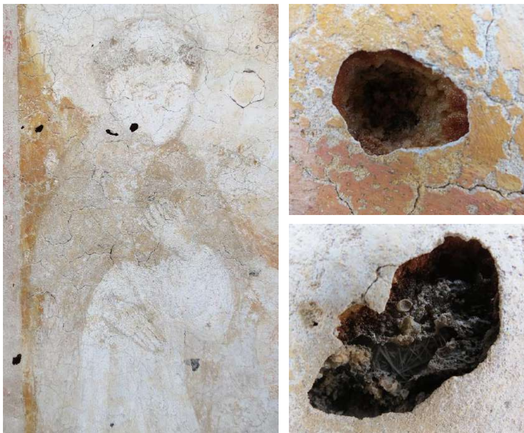
Figura 36: I fori presenti nell'affresco dai quali si intravede il poliuretano espanso e la lana di vetro usati durante l'intervento di stacco e spostamento dell'icona
