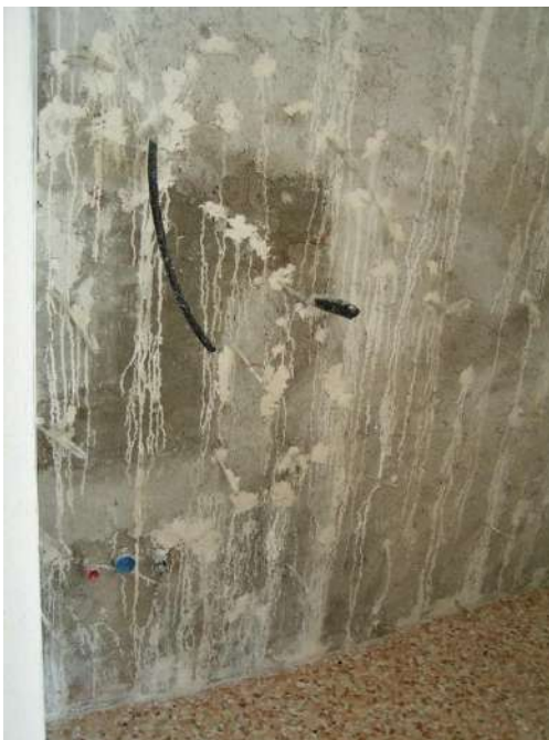
Figura 45: L'iniezione del Ledan dopo il rinzafo e il puntellamento esterno per evitare che la pressione del liquido provochi spanciamenti
