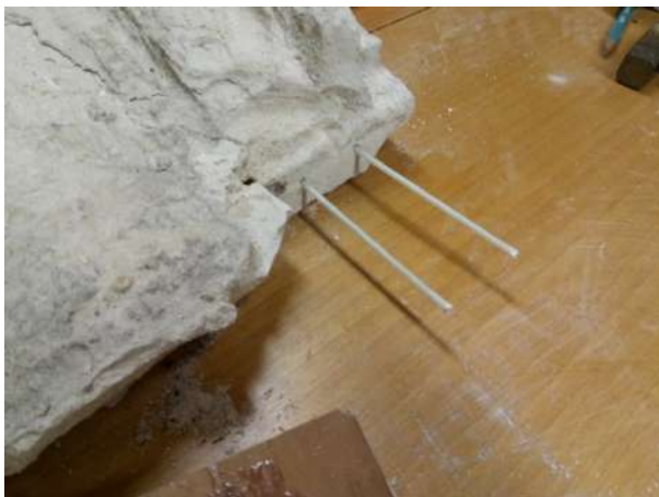
Fig. 10 – Inserimento perni e maglia in vetro resina
