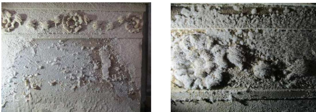
**Img 26 – efflorescenze, basamento destro, fotografia con luce radente**
