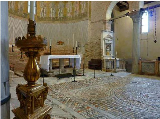
Figura 9. Vista degli avvallamenti e delle disconnessioni del pavimento
