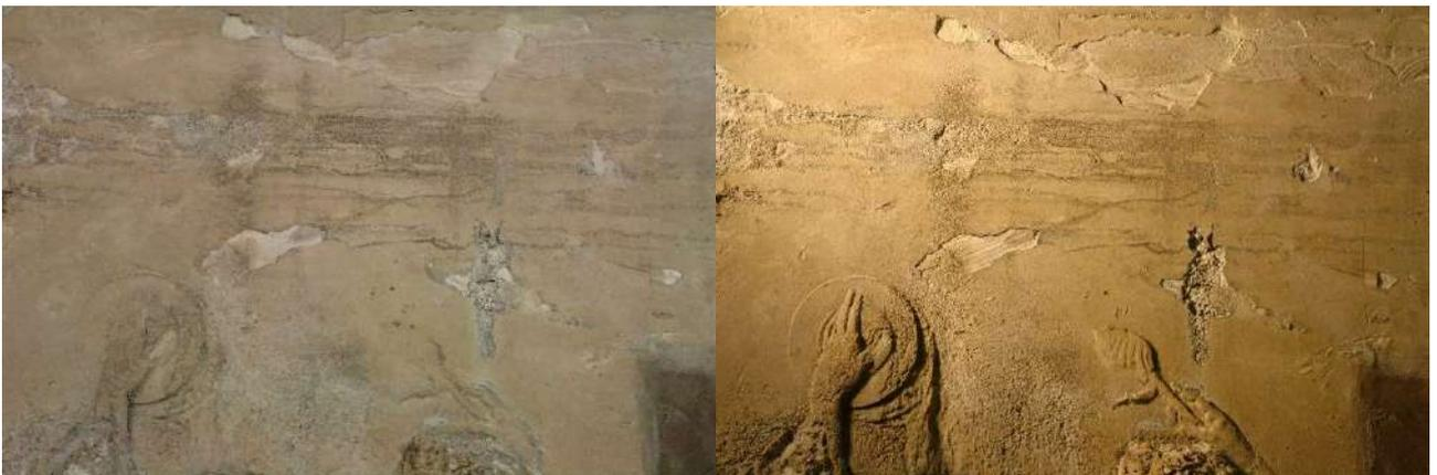
*Figura 10: Esfoliazione, particolare con luce frontale e con luce radente*
