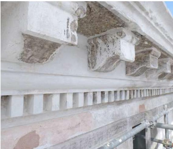
asportate quasi esclusivamente le stuccature in fase di distacco e degradate. Si sono stuccate tutte le lesioni, fessure e microfessure con impasto di calce Lafarge, sabbia e polvere di marmo e ripristinate le pendenze delle trabeazioni dei portali e delle porte finestre con la stesura di uno spessore inclinato "copertina" di malta fibrorinforzata della MGN.
