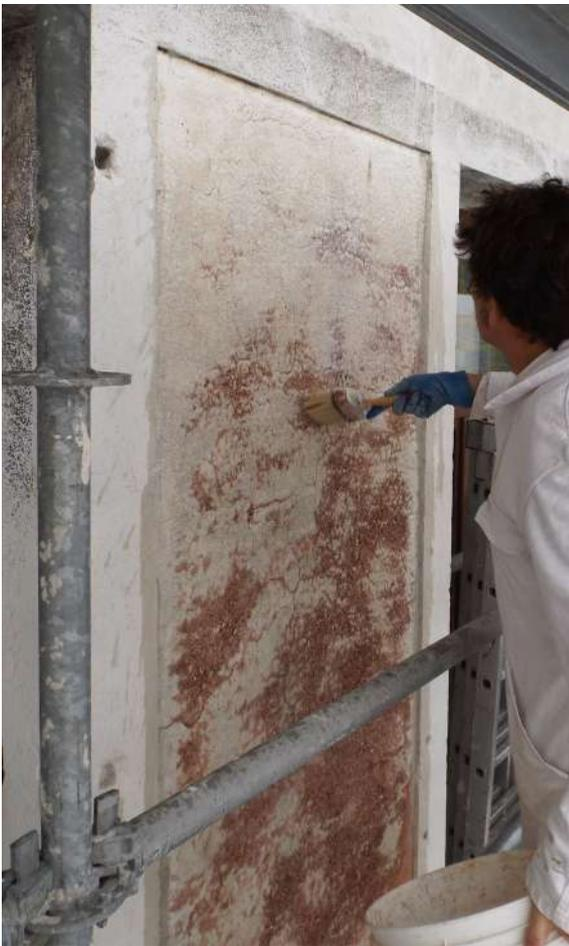
In buona parte di entrambe le facciate in esame, si è rilevata la presenza di finitura a marmorino su base di cocciopesto, solo nelle prime due campiture basse tra i marcapiani del fronte ovest, prospiciente il canale, la perdita di intonaco era totale. Infatti la posizione del prospetto a diretto contatto con l'acqua e la conseguente risalita di sali è la principale causa del loro distacco.
