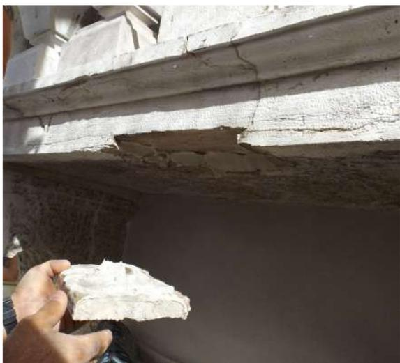
*Fig. 24. Inserimento perni in acciaio in una porzione di architrave staccato.*
