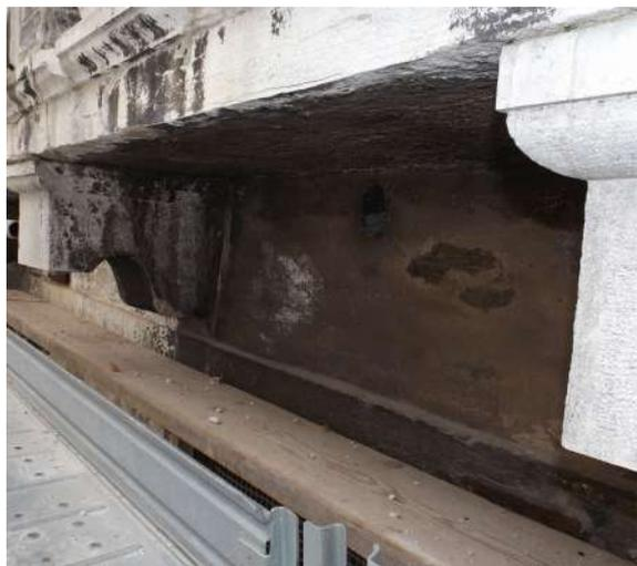
Fig. 17. Presenza di croste nere nel cornicione.
