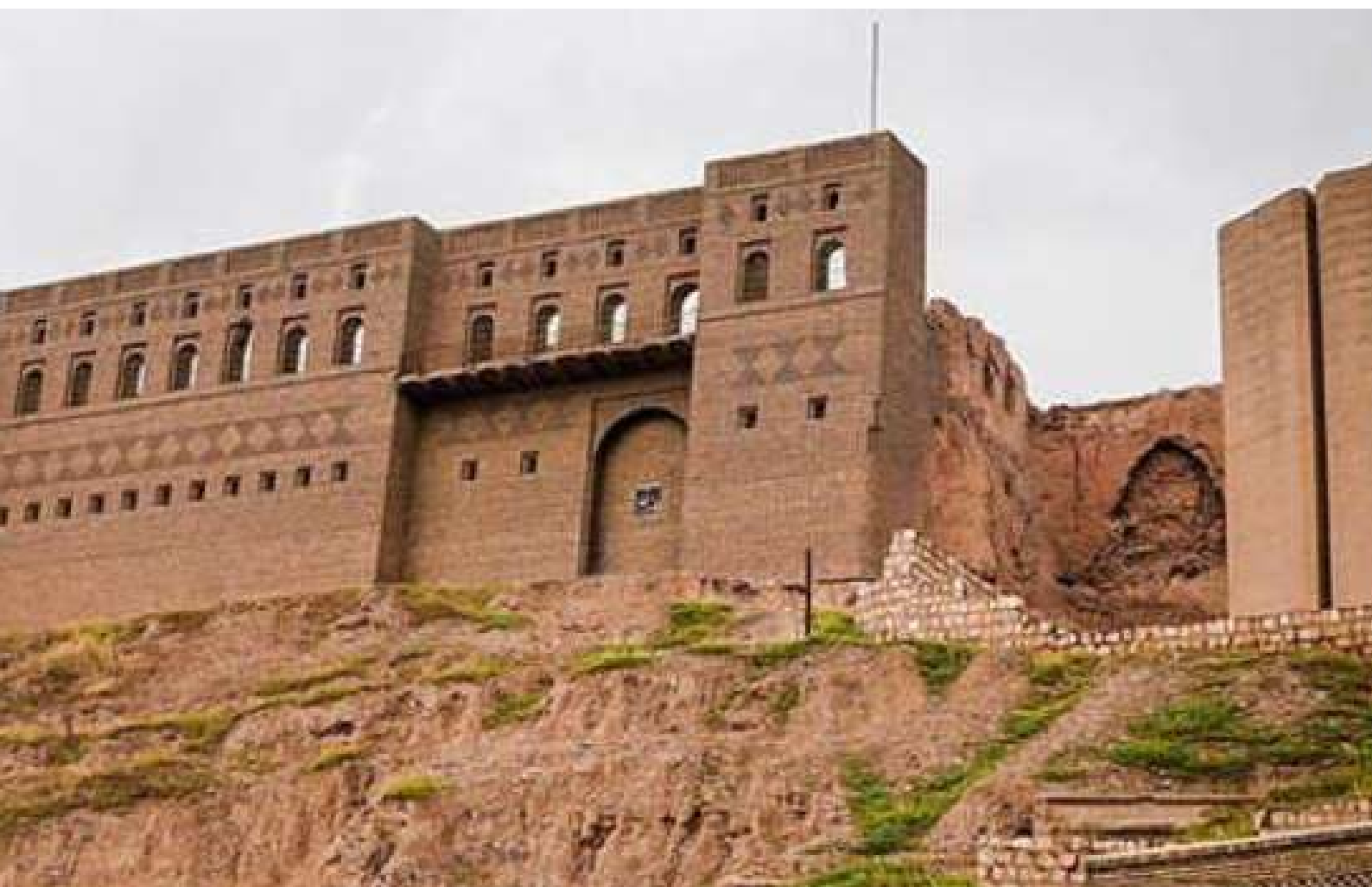
Erbil, dettaglio della Cittadella; ottobre 2019
