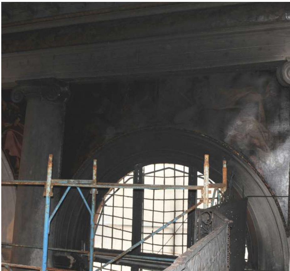
La finestra a Ovest della Chiesa da dove sono entrate e si sono propagate le fiamme
