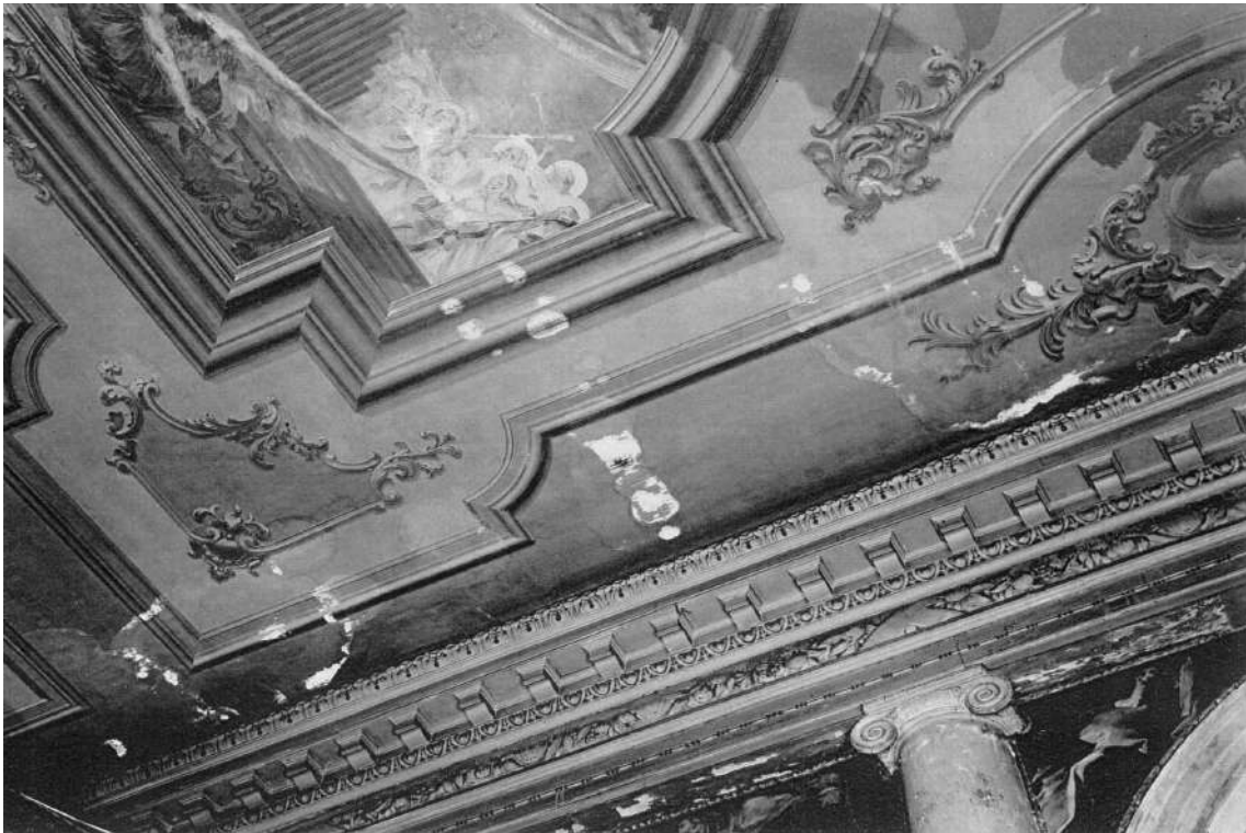
Il soffitto nel 1972, particolare, Archivio IRE
