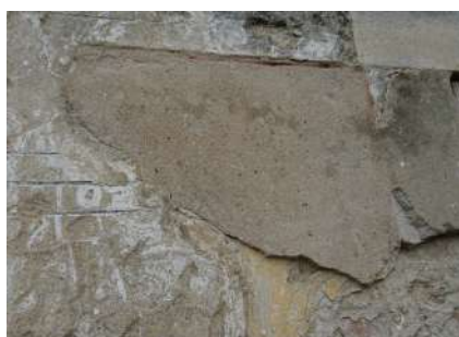
Foto 39. Fronte est. Strato 5.
