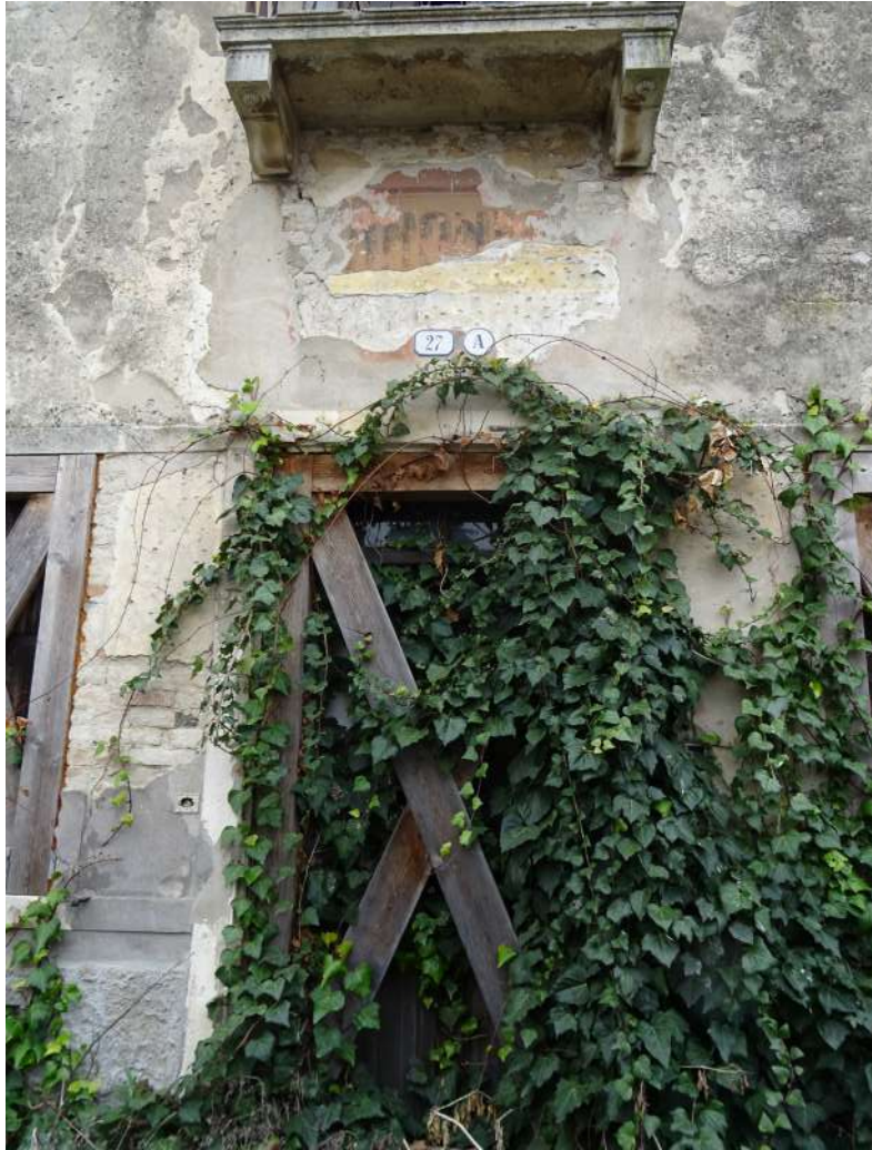
Foto 26. Fronte est, ingresso.
