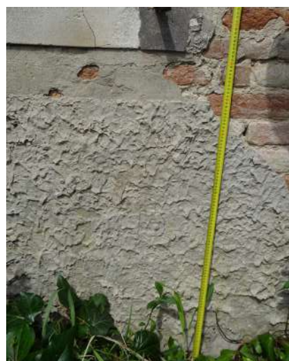
Foto 42. Fronte est. Strato 8.
