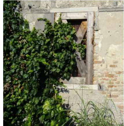
Foto 38. Fronte est: vegetazione superiore.
