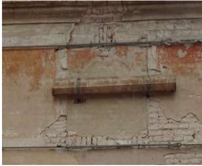
Foto 23. Fronte sud. Finestra del secondo piano.
