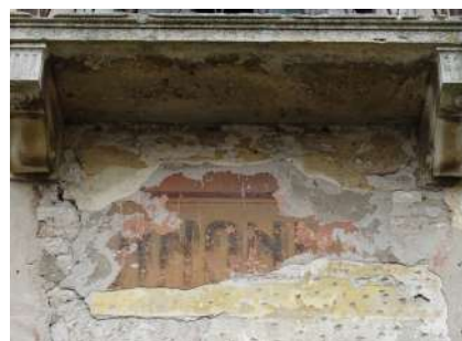
Foto 43. Fronte est. Particolare scritta CANONICA
