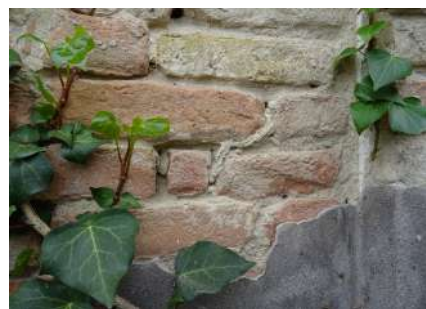
Foto 35. Fronte est. Strato 1.
