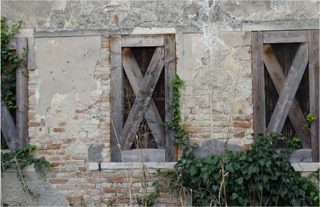
Foto 47. Fronte est. Area del prelievo dei campioni di intonaci.
