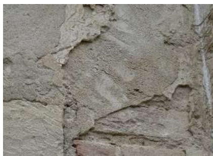
Foto 36. Fronte est. Strato 2.
