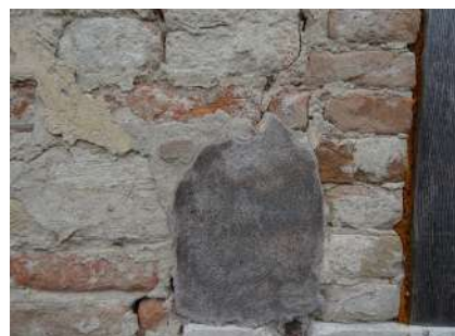
Foto 41. Fronte est. Strato 7.
