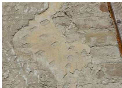
Foto 37. Fronte est. Strato 3.
