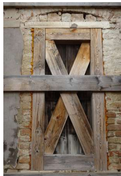
Foto 22. Fronte sud. Finestra del piano terra.
