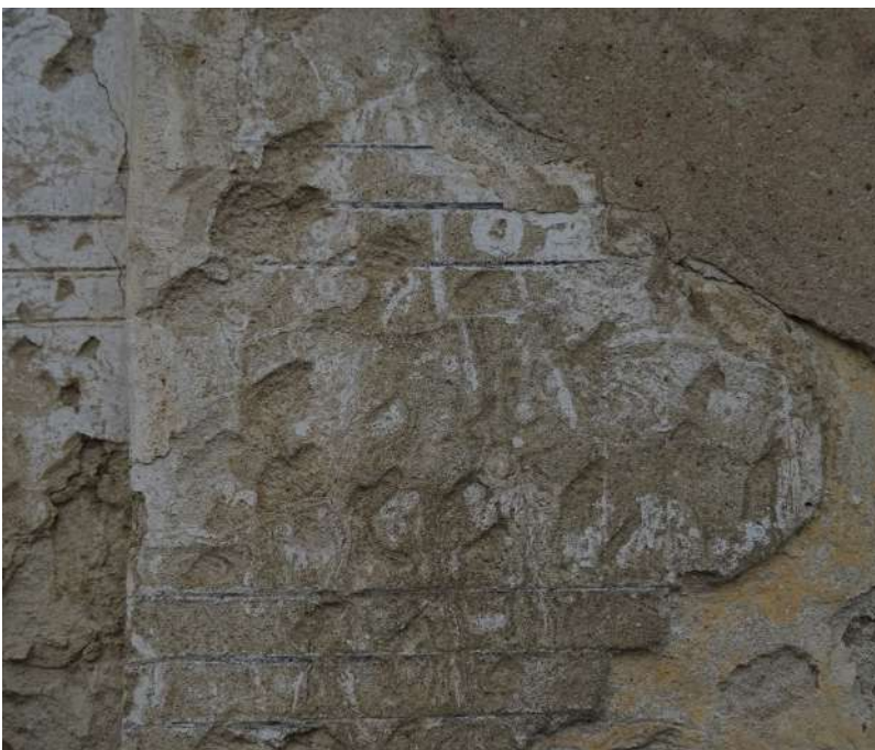
Foto 25. Motivo decorativo a rilievo dell'intonaco del fronte est.
