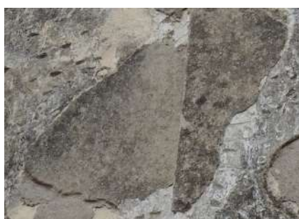
Foto 40. Fronte est. Strato 6.
