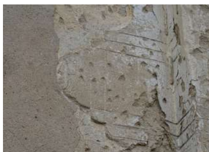
Foto 38. Fronte est. Strato 4.
