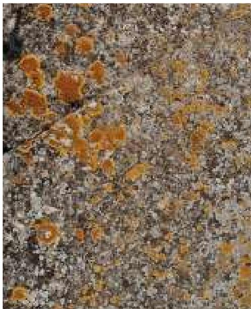
Fig.11 Dettaglio del biodegradamento presente sulla superficie della peschiera.
