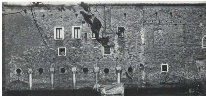
Figura 2. Complesso monastico di San Nicolò del Lido. Parete settentrionale esterna in cui sono visibili i resti della basilica dell'XI secolo, ovvero le cinque colonne con i rispettivi capitelli, le arcate e alcune tracce di monofore.
