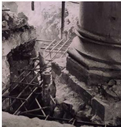
Fig. 24. Gli scavi per rafforzare le fondazioni
