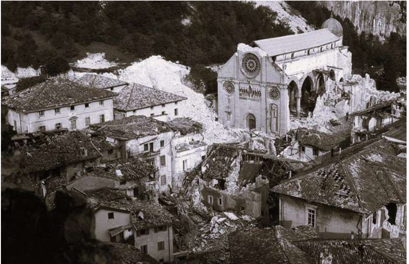
Fig. 5. Dopo le due scosse di settembre 1976: rispetto alla fotografia precedente si vede che è crollato definitivamente il campanile, il timpano in facciata, e la navata destra ha subito ulteriori danni.
