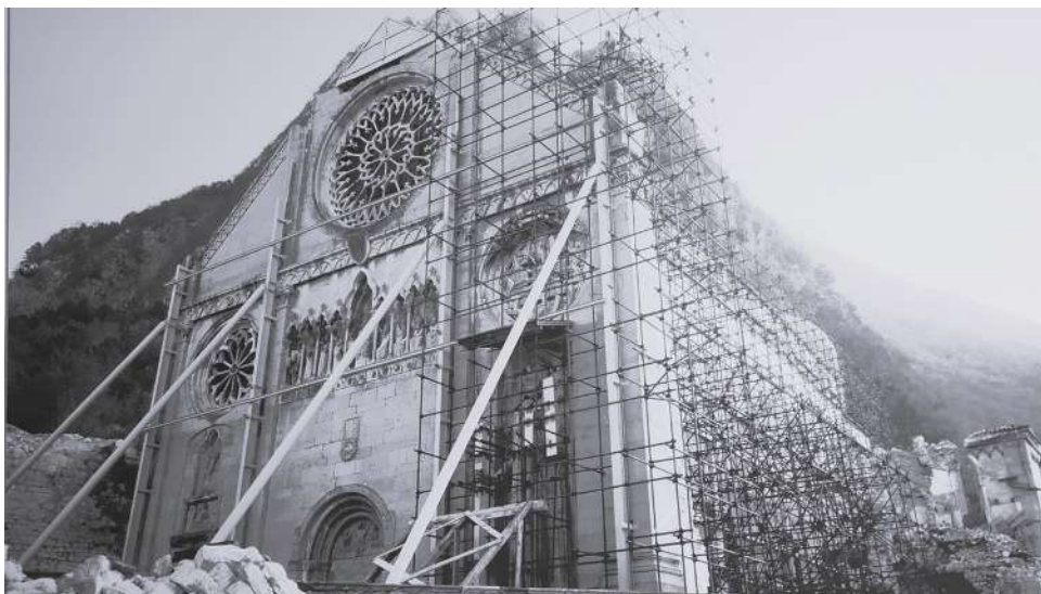
Fig. 13 (in alto) Opere di puntellamento dell'intero edificio.
