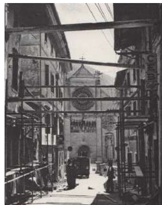
Fig. 15 (in basso) Opere di puntellamento di tutta via Bini.
