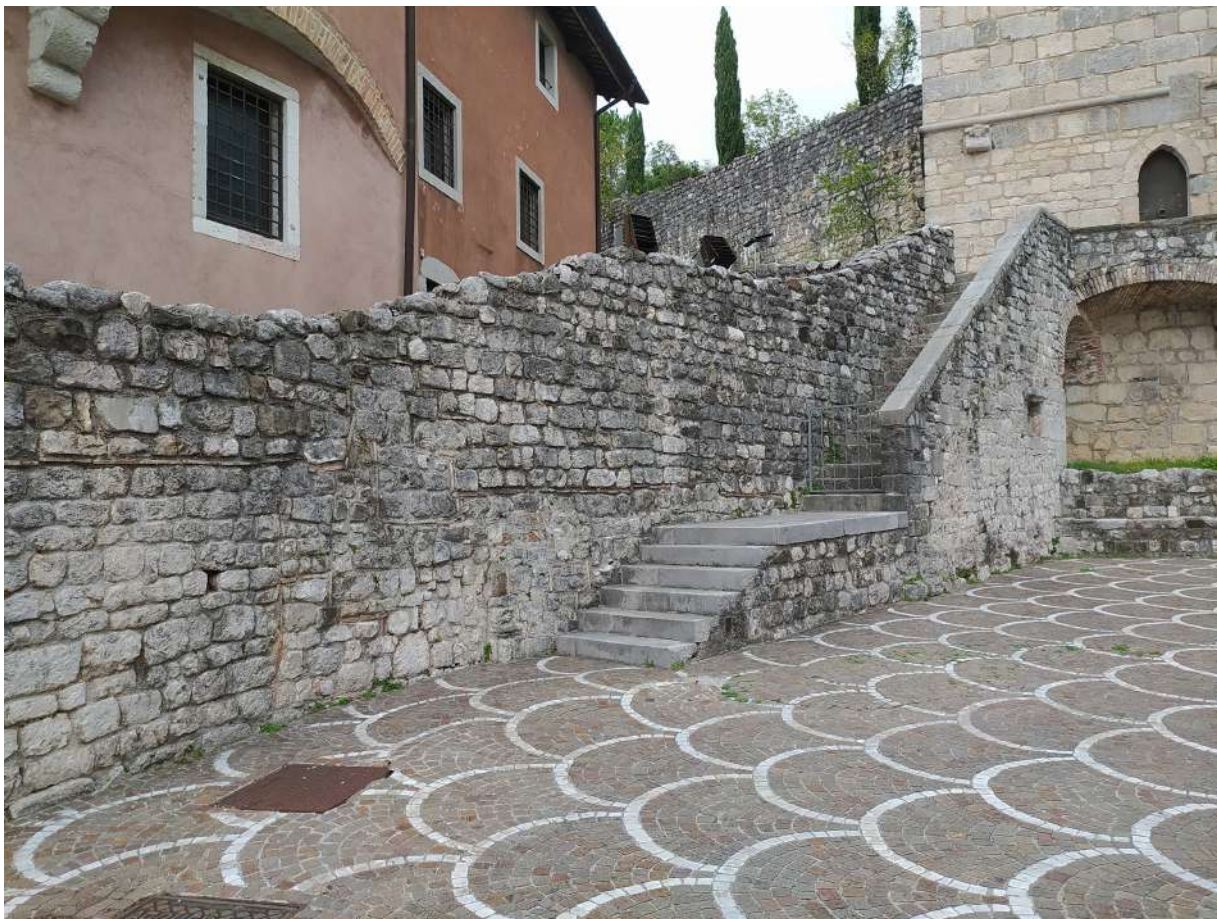
Fig. 26. Sul muro di delimitazione del piazzale del Duomo, vi è stata lasciata traccia della sezione rimasta dal terremoto tramite una fila di tavelle in cotto. Lo stesso principio è stato applicato al campanile.
