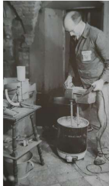
Fig. 2.9. Preparazione della barriera in resina poliestere, marzo 1969.
