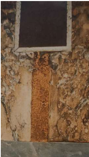
Fig. 2.11. Stato di conservazione delle lastre lapidee prima del restauaro.
