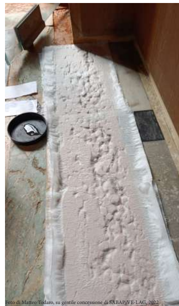
Fig 3.6. Applicazione dell'impacco desalinizzante su una lastra posta all'ingresso.
