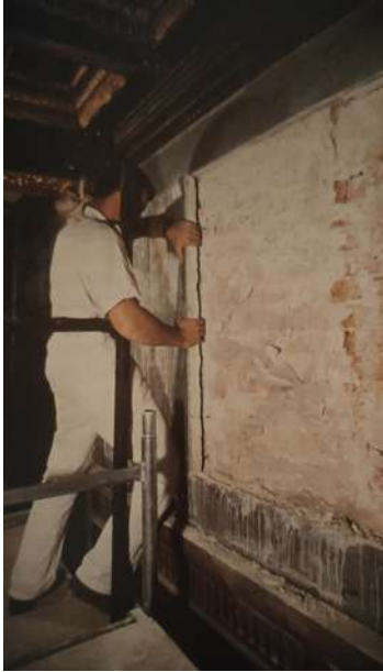
Fig. 2.10. Lavori di rimozione delle lastre marmoree della parete destra
