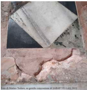
Fig 3.4. Fondo di una formella lapidea dopo l'intervento di pulitura.
