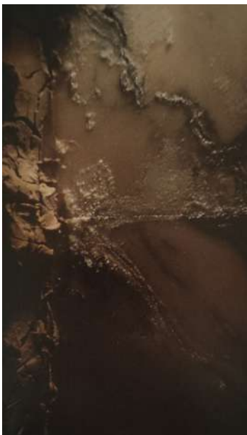
Fig. 2.14. Impacco di desalinizzazione applicato sulle lastre marmoree.
