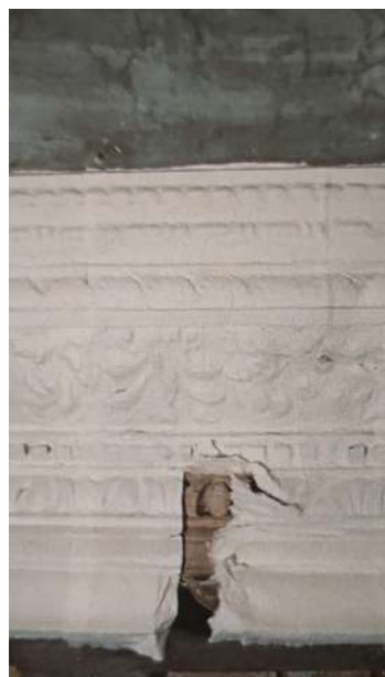
Fig. 2.13. operazione di pulitura mediante l'applicazione di impacchi sugli elementi lapidei interni.
