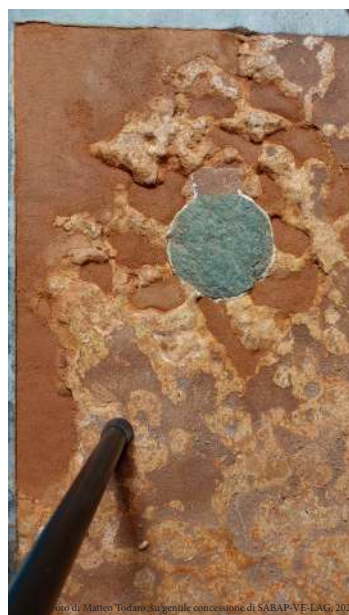
Fig 3.10 b. Integrazione a livello mediante la stesura della maltina finale.
