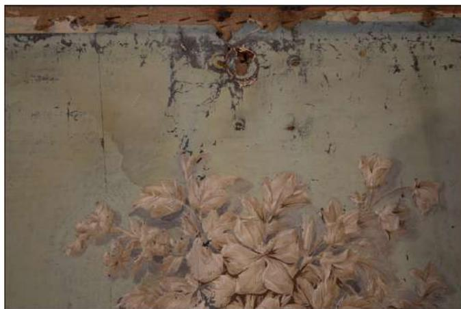
*Fig. 25: Particolare della lacuna di forma circolare che fa pensare alla precedente presenza di una maniglia*
