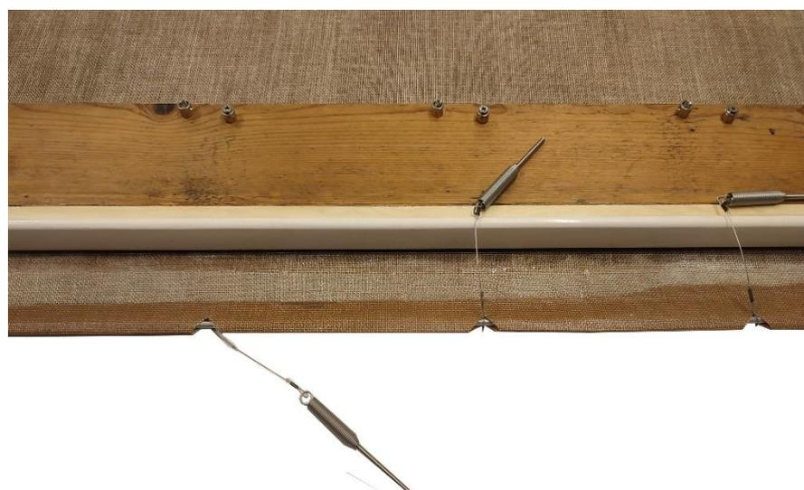
Figura 34 Dettaglio del posizionamento delle molle lungo i margini di scorrimento
