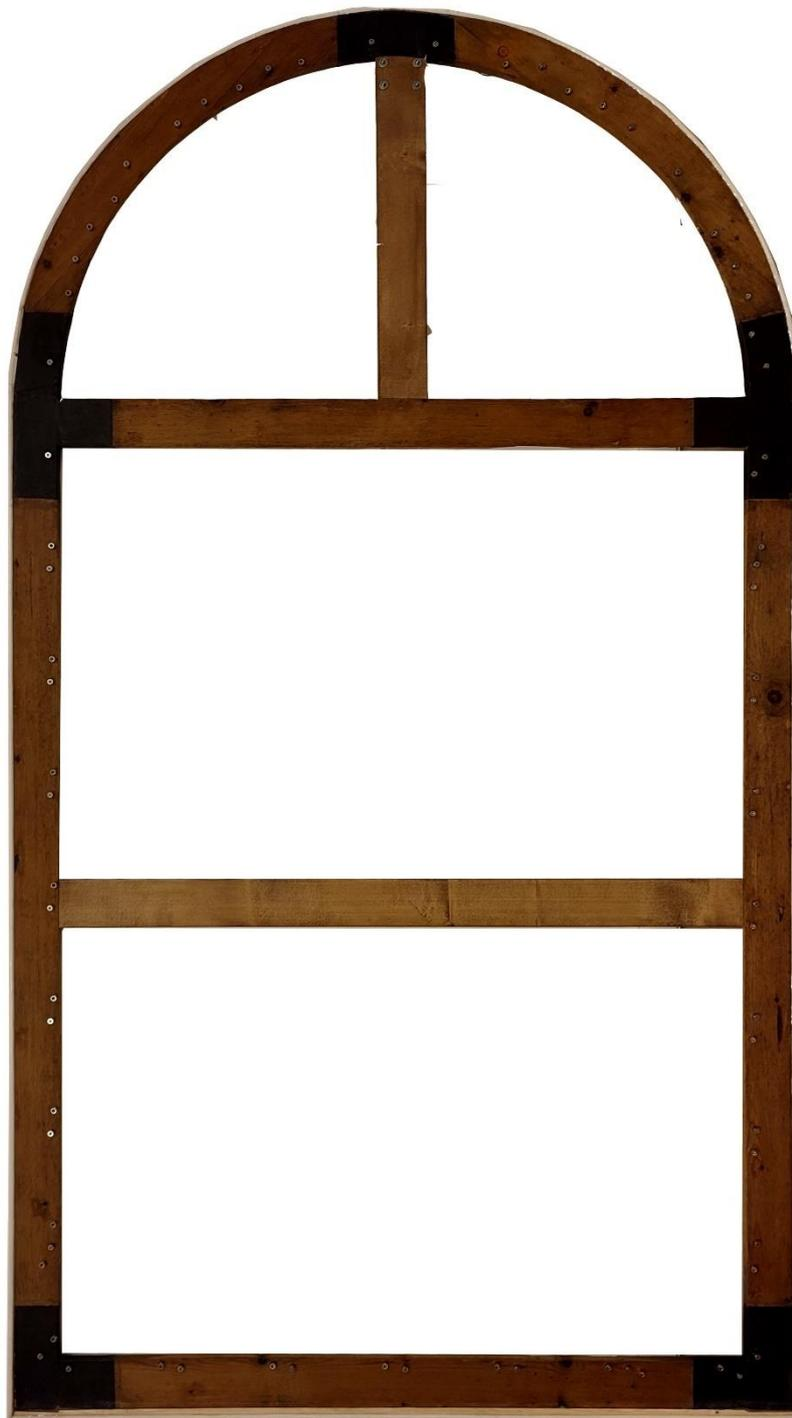
Figura 28 Telaio al termine del restauro strutturale
