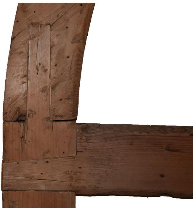
Figura 4 Incastro a mezzo legno e tenone che lega la centina alla parte rettangolare del telaio
