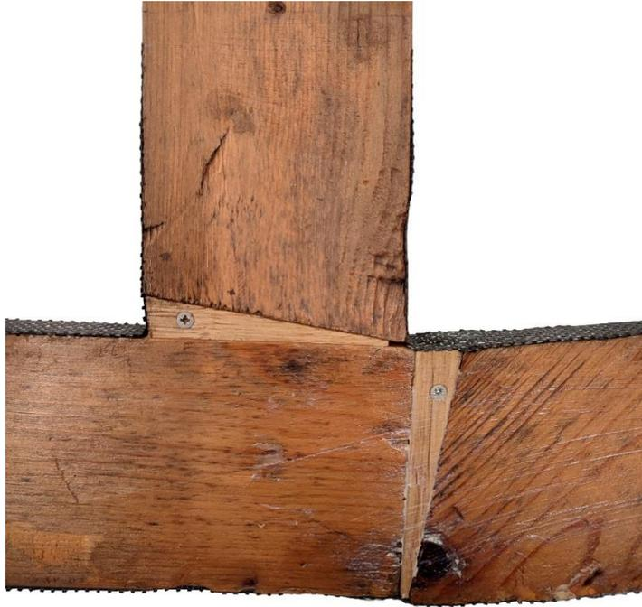
Figura 24 Dettaglio del rinforzo dell'incastro
