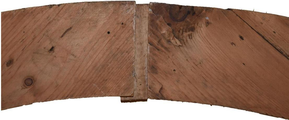
Figura 2 Centina - incastro tenone-mortasa
