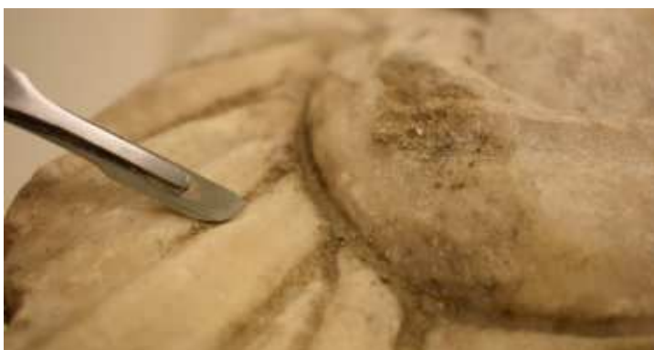
Fig.16 rimozione di malta residuale con bisturi
