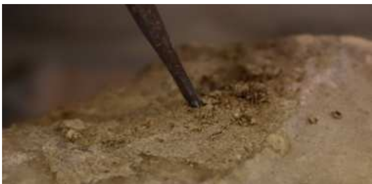
Fig.15 rimozione della malta con scalpello
