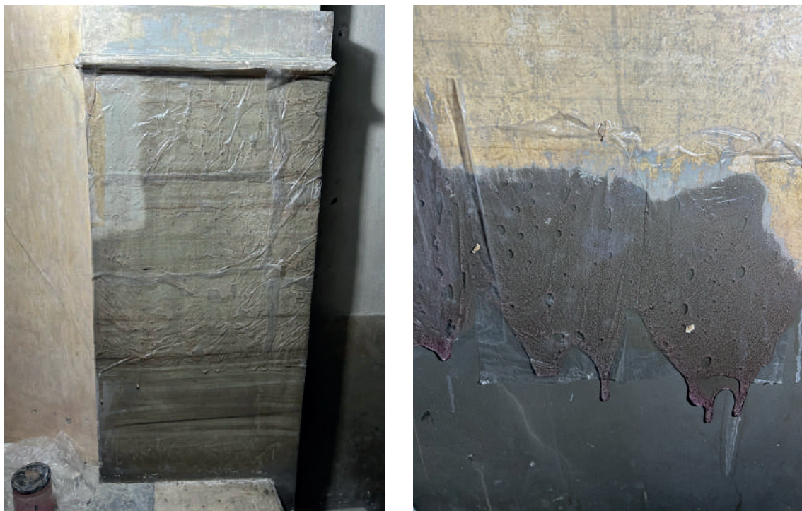
Fig. 38 - 39 - Impacco di Klucel G nella parete in marmorino per il descialbo dagli strati di tempera
