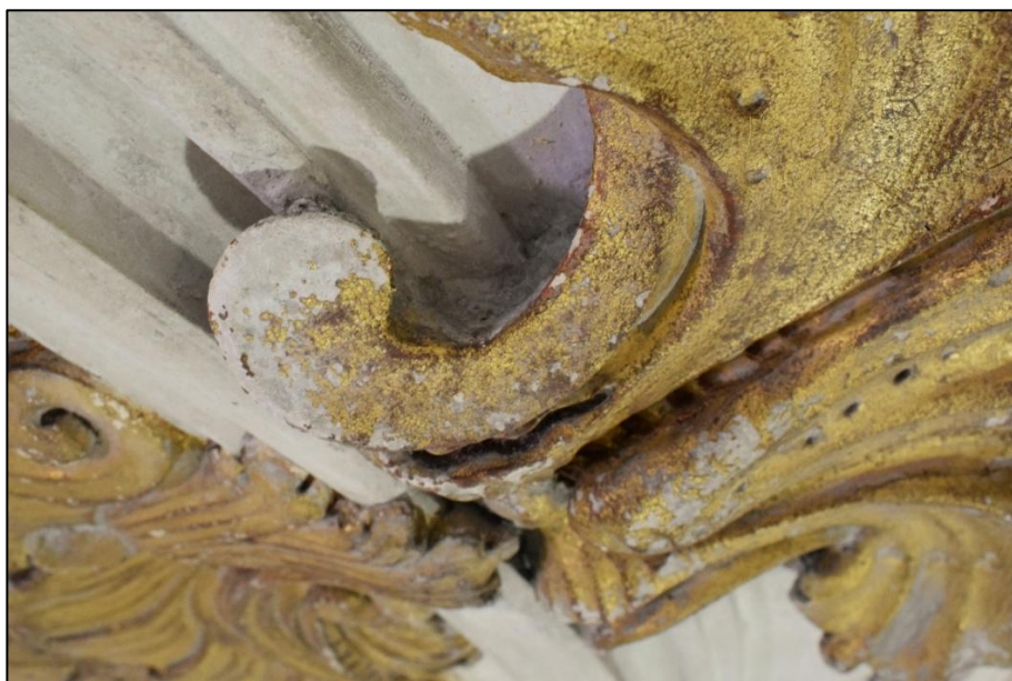
Fig. 40. Immagine autoprodotta, dettaglio mancanza foglia d'oro pre intervento di restauro del soffitto della Sala d'Oro, 2025
