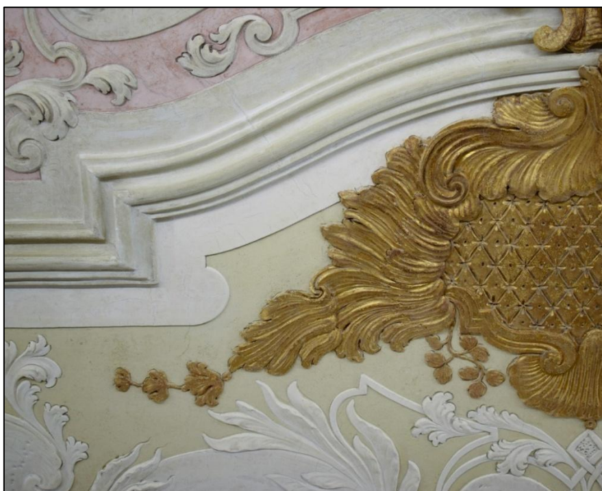
Fig. 48. Immagine autoprodotta, dettaglio post ritocco pittorico del soffitto della Sala d'Oro, 2025
