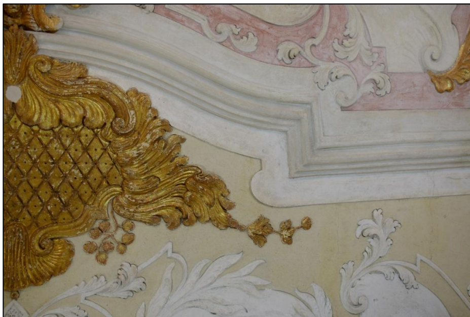
Fig. 45. Immagine autoprodotta, dettaglio post intervento di pulitura del soffitto della Sala d'Oro, 2025
