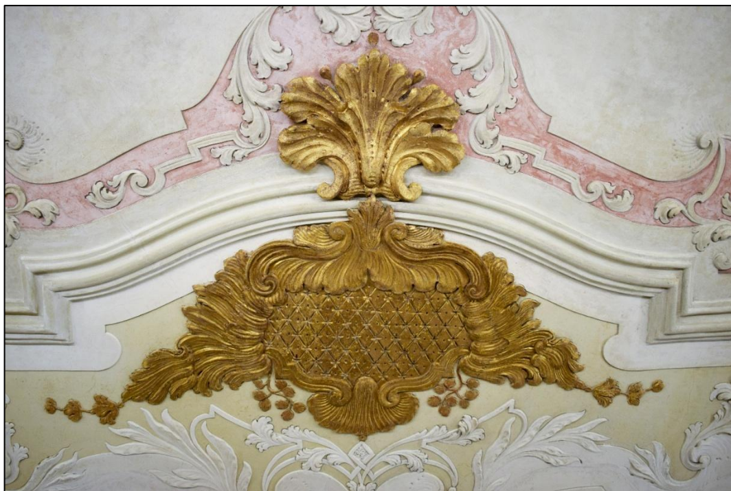
Fig. 57. Immagine autoprodotta, post intervento di restauro Sala d'Oro, 2025
