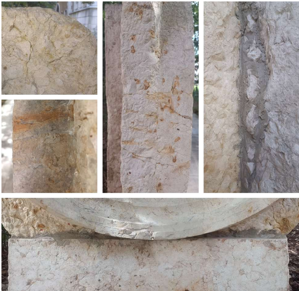
Fig.58-62: Dettagli delle zone d'intervento. Foto dell'autrice, settembre 2025
