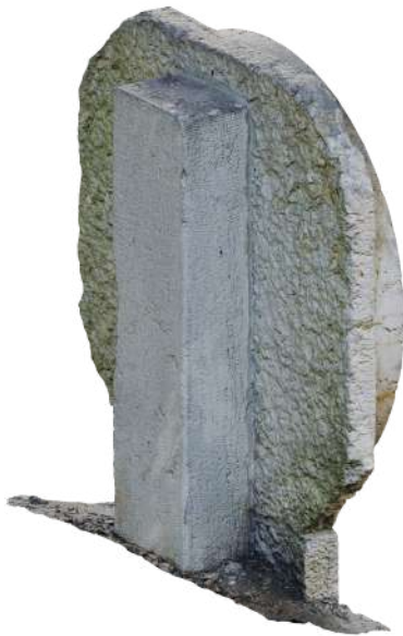
Fig.35: Modello 3D ottenuto mediante tecnica fotogrammetrica sviluppata con Metashape. Agosto 2025
