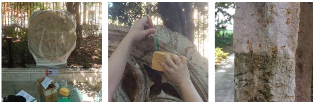
Fig. 2: Applicazione integrale della soluzione scelta e successivo risciacquo della superficie
