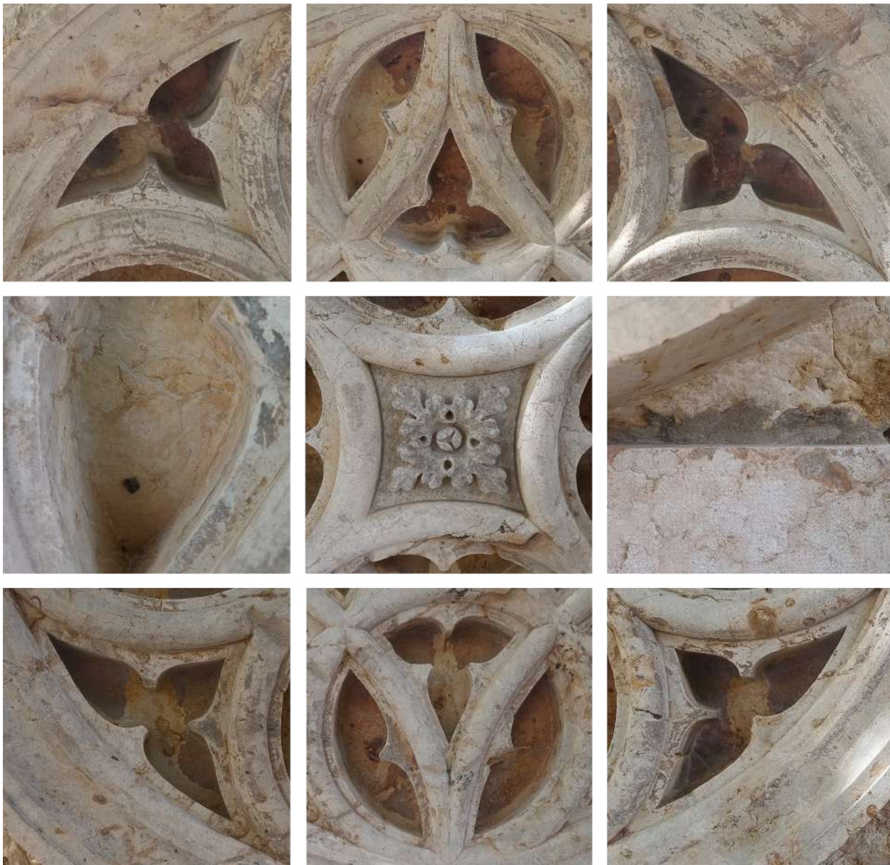
Fig.49-57: Dettagli delle zone d'intervento. Foto dell'autrice, settembre 2025
