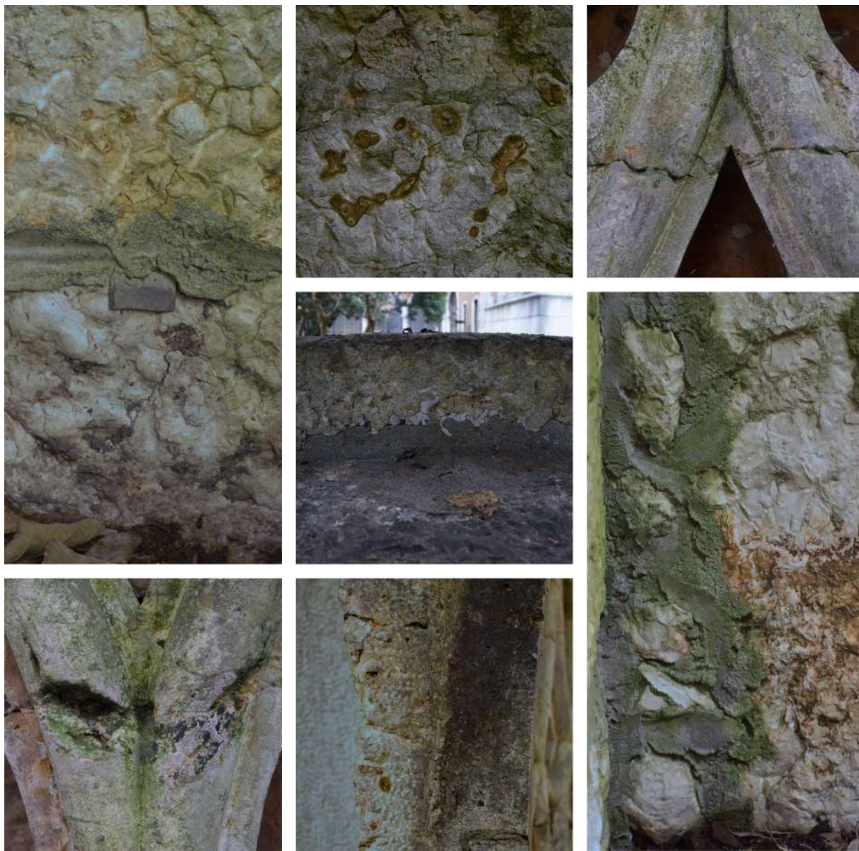
Fig.27-33: Dettagli delle forme di degrado riscontrabili sul manufatto: colonizzazione biologica, macchie, lesioni, stuccature preesistenti non completamente adese, assenza di modellato e patina biologica di colore nero-bruno. Foto dell'autrice, febbraio 2025
