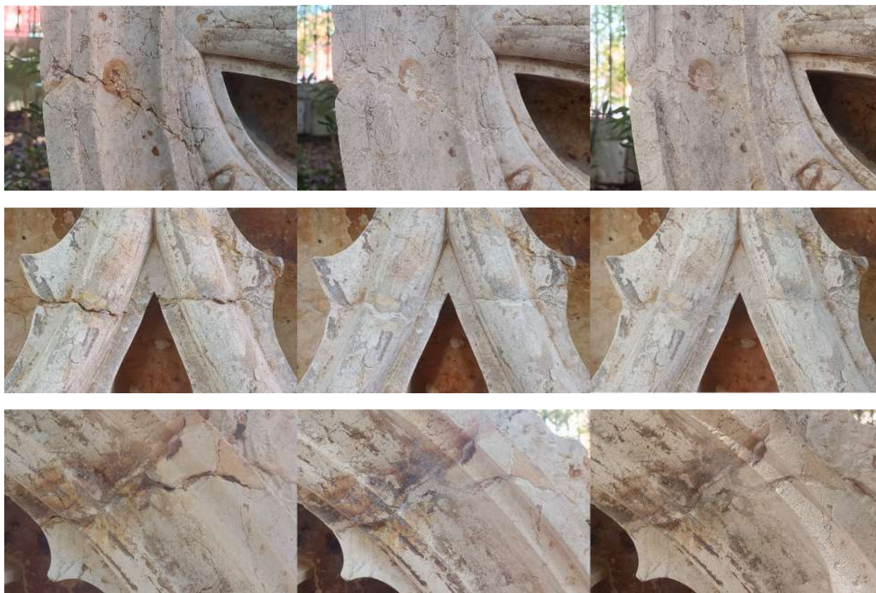
Fig.41-43: Sequenza di realizzazione di alcune stuccature (pulitura delle lesioni, stuccatura in opera, correzione cromatica)
