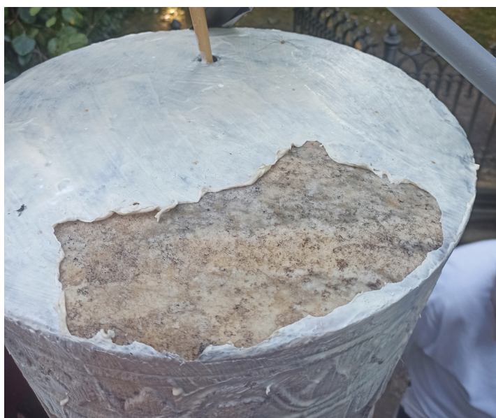
Figura 4. Rimozione dello strato di lattice, 2024 (foto di S.Volpato).
