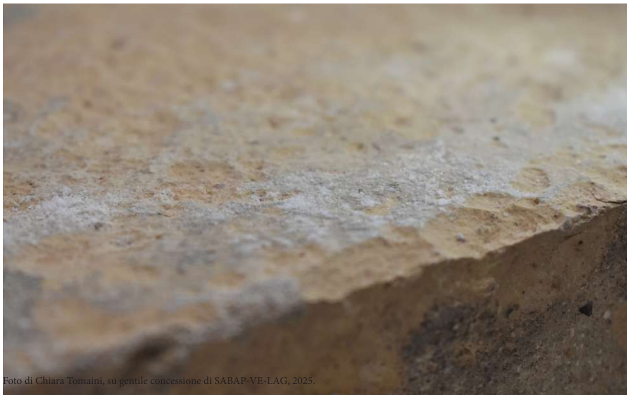
(Fig. 2) Dettaglio di efflorescenze saline.
