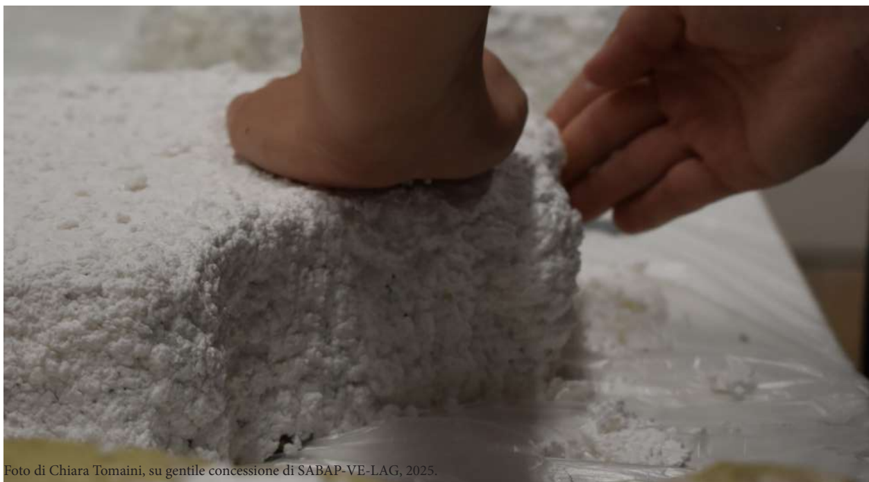
(Fig. 4) Applicazione dell'impacco desalinizzante.
