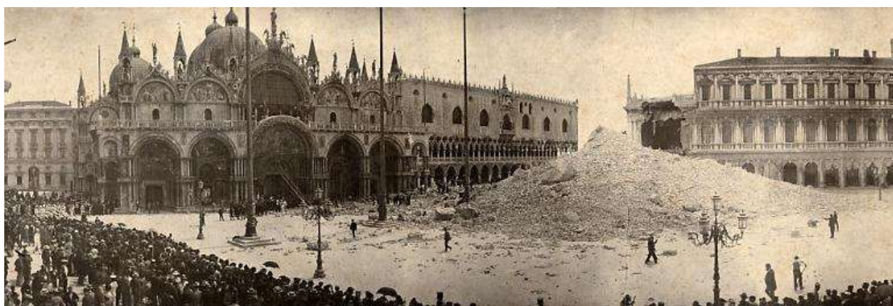
(Fig.3) Una panoramica di Piazza San Marco dopo il crollo del campanile il 14 luglio 1902.
